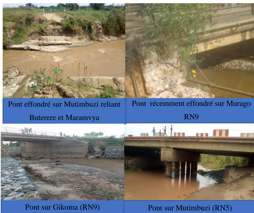
Figure II-5 : Les ponts sur la rivière Muzazi et ses affluents
