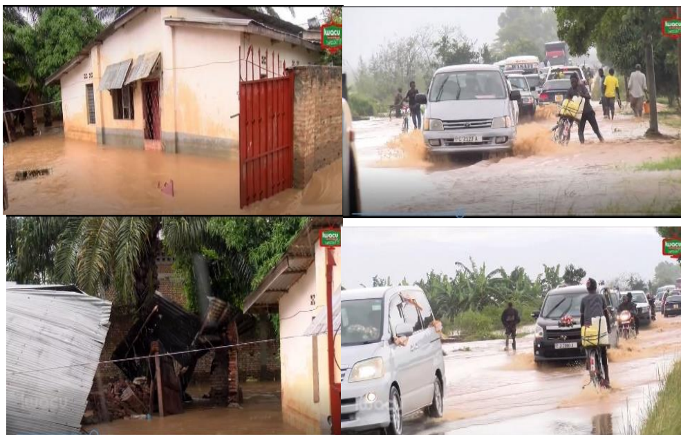
Figure II-2: Dégâts causés par la rivière Mutimbuzi en 2018
