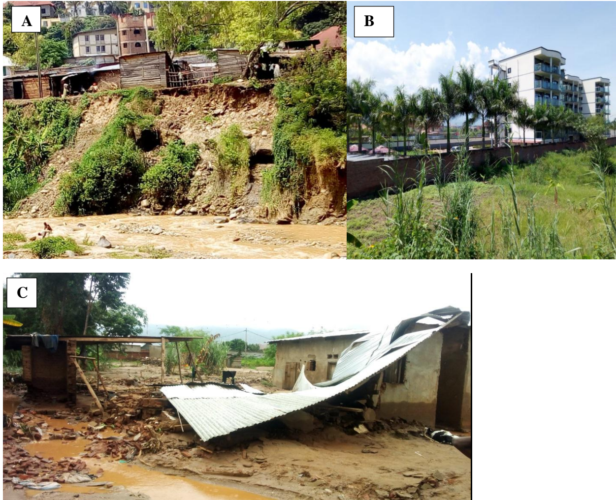
Figure 5: Illustration des maisons non en dur sur la rivière Ntakangwa (A), la maison en dur sur la rivière Muha (B) et la maison intermédiaire sur la rivière Kanyosha (C)
