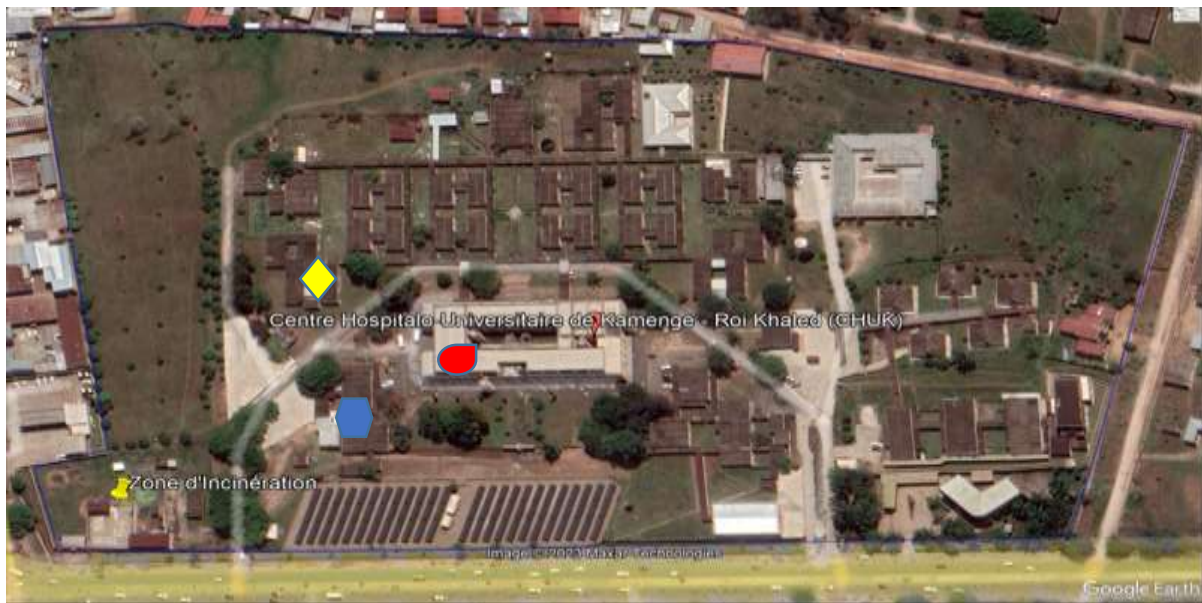
Figure 9: Photographie du Centre Hospitalo-Universitaire de KAMENGE
