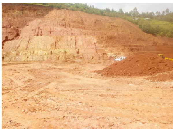
Figure 4: Illustration des dégâts sur le sol
