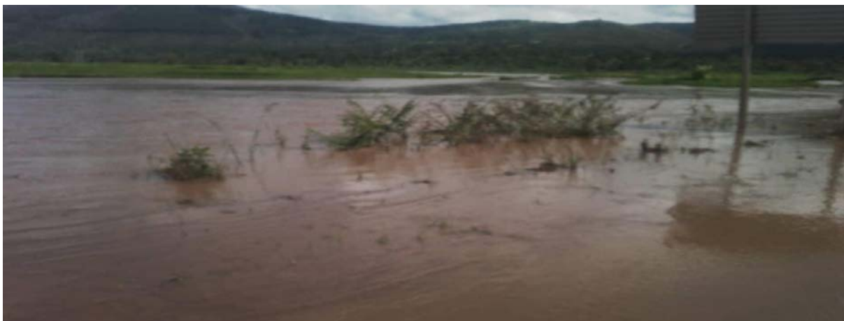
Figure I. 2 : Photos illustrant les dégâts de débordement des eaux de MUSASA sur les champs et l'infrastructure routière de la RN 11
