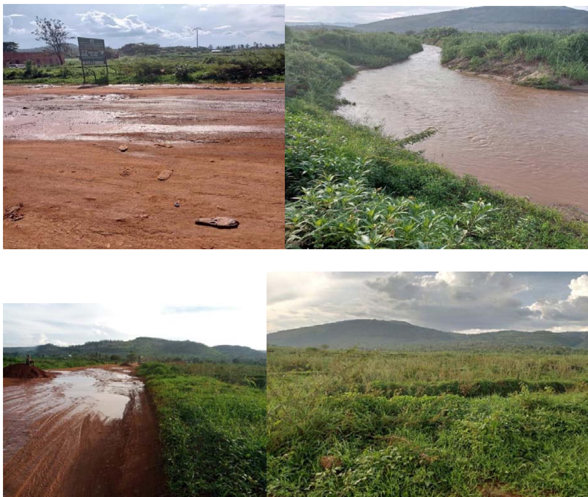
Figure I. 1: Photos prises le 16/12/2022 à 15h00min illustrant les dégâts causés par la rivière MUSASA sur la Route Nationale Numéro 8 (RN8)
