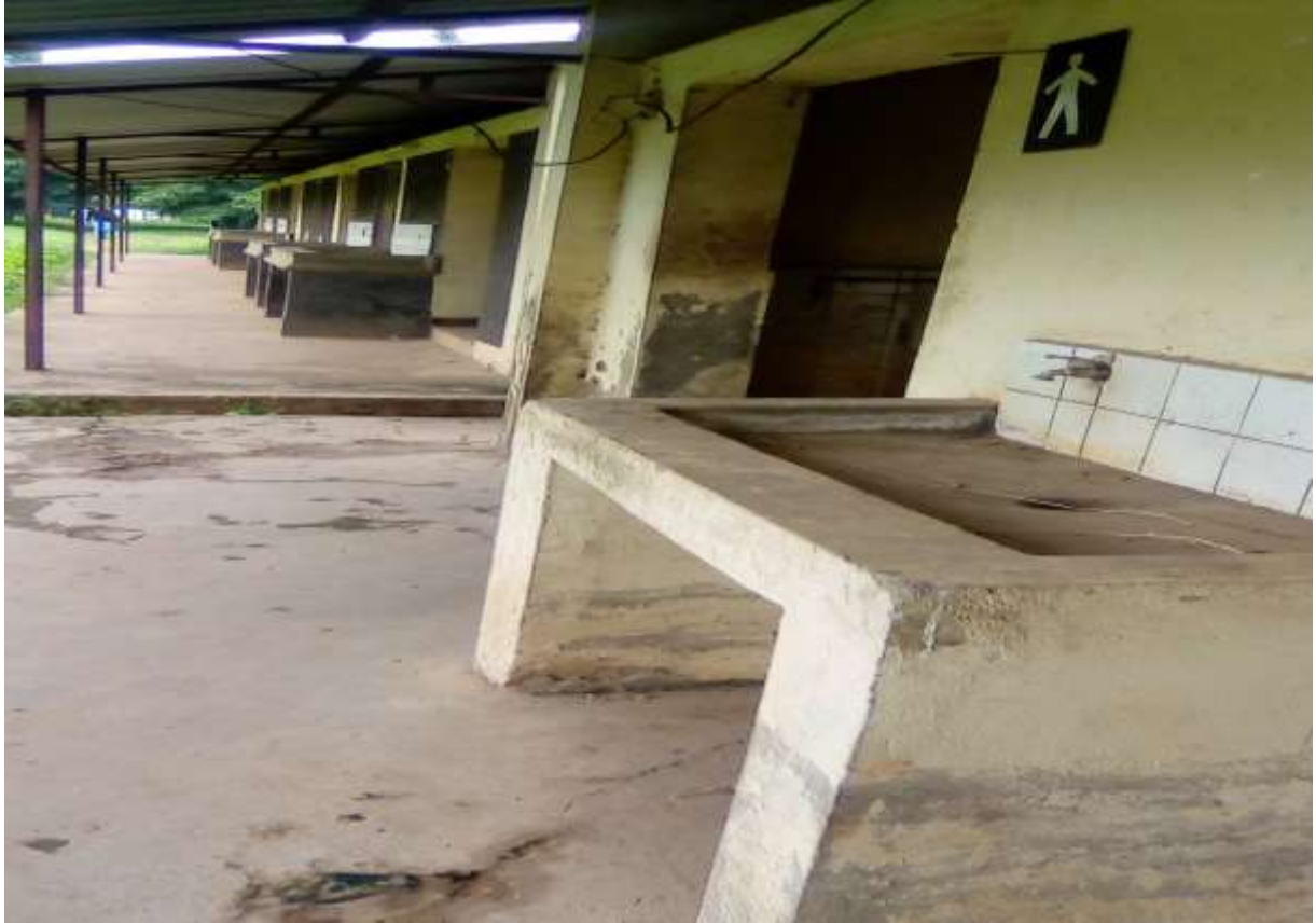
Image 3. Les infrastructures sanitaires du campus Mutanga.
