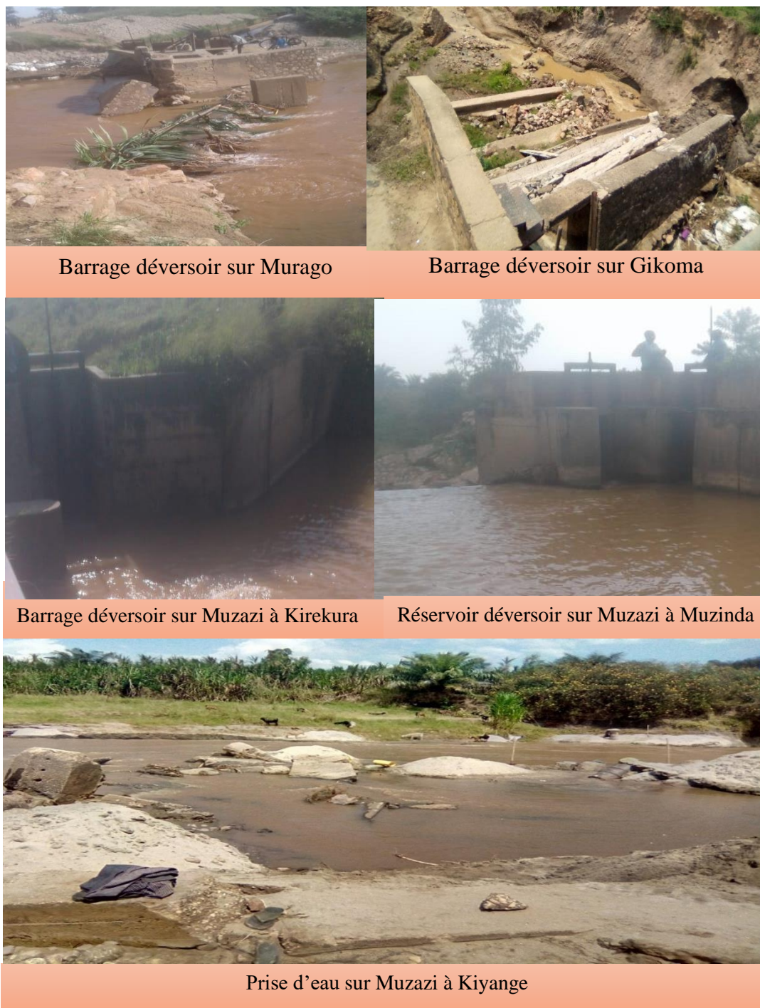
Figure II-4 : Photos prises sur terrain de prises d'eau existant sur la rivière Mutimbuzi et ses affluents
