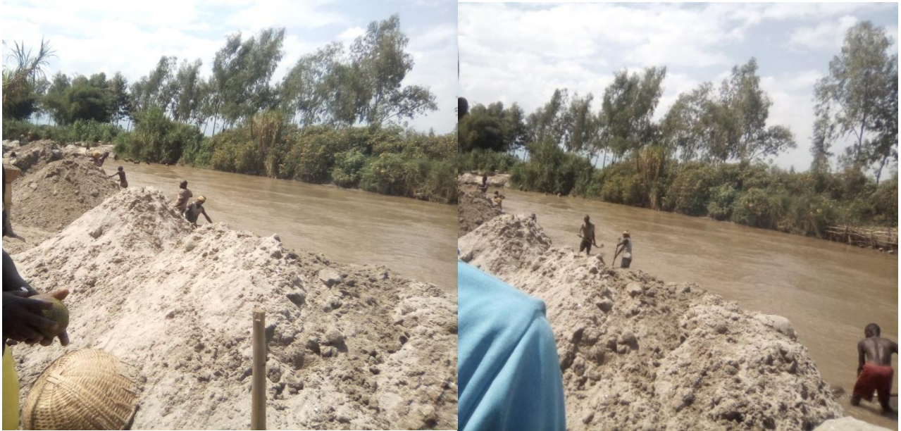
Figure II-3 : Photos prises sur terrain des travaux de curage sur la rivière Mutimbuzi
