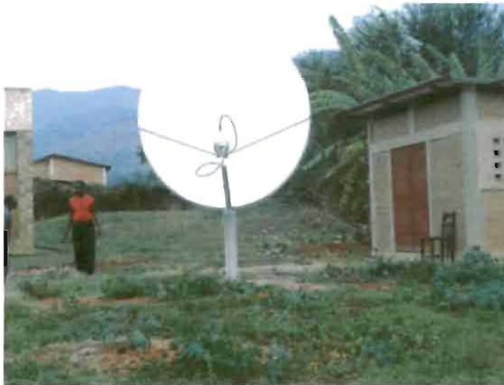
Figure 8: Antenne VSAT bande C de l'Université du Burundi
