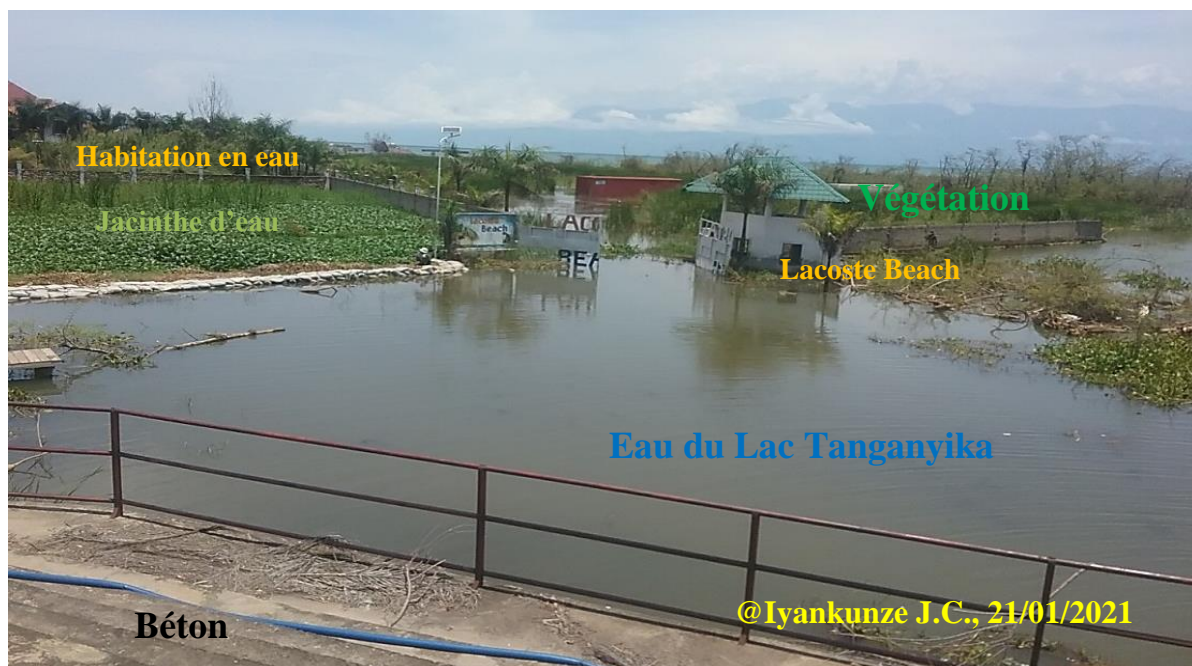
Photo 4.7. Lacoste Beach noyé complètement dans les eaux du lac Tanganyika
