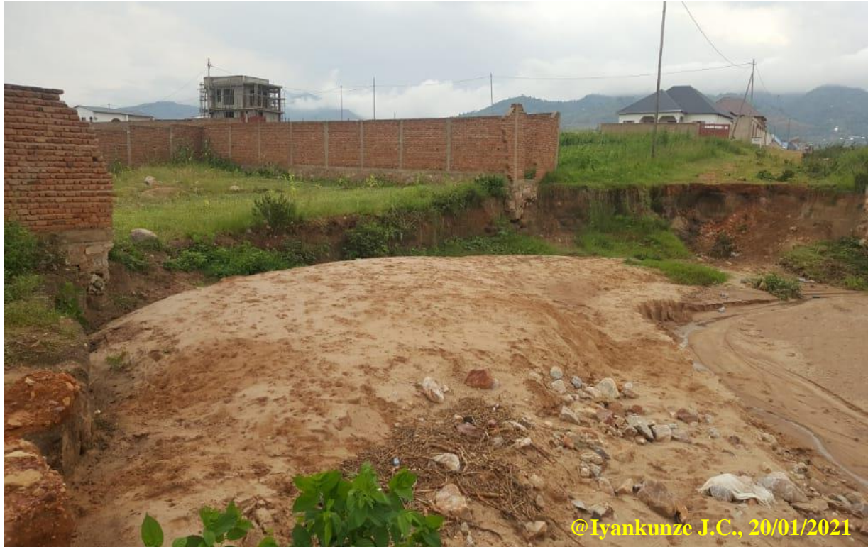
Photo 3.1. Effondrement sur la rive gauche, destruction des enjeux et alluvionnement sur la rive droite d'un canal d'évacuation des eaux à Nyabugete I, à 350 m du lac Tanganyika
