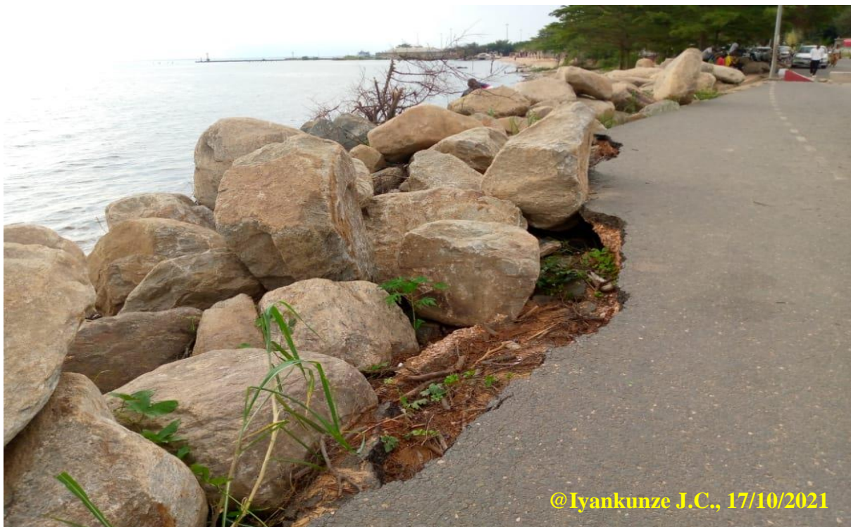
Photo 4.14. Enrochement de pied de la rive du lac Tanganyika pour protéger le Boulevard du Japon
