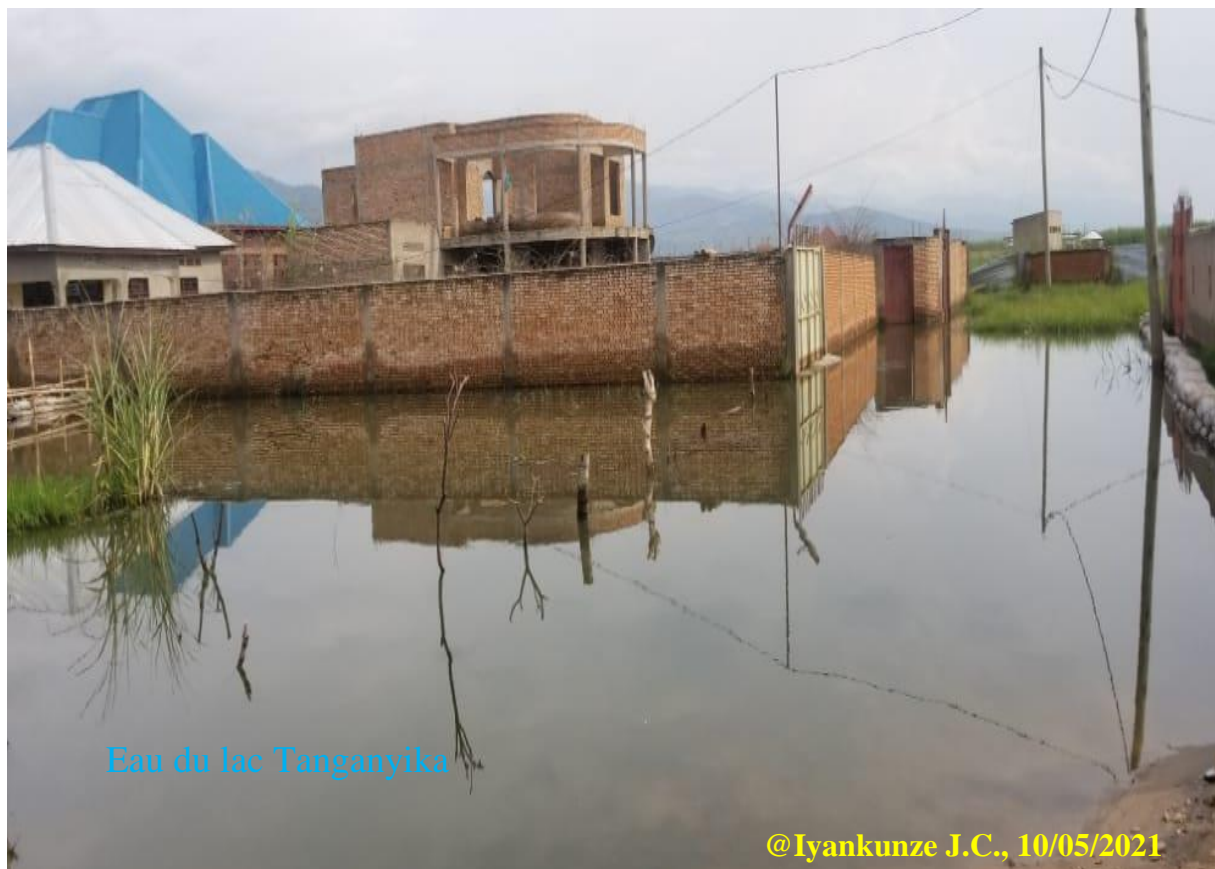
Photo 4.11. Erection des maisons de grande fortune sur le site inondé à Kibenga
