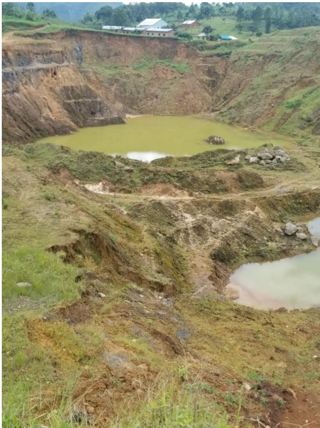
Photo illustrant les menaces d'effondrement des classes de l'ECOFO Gahoma
