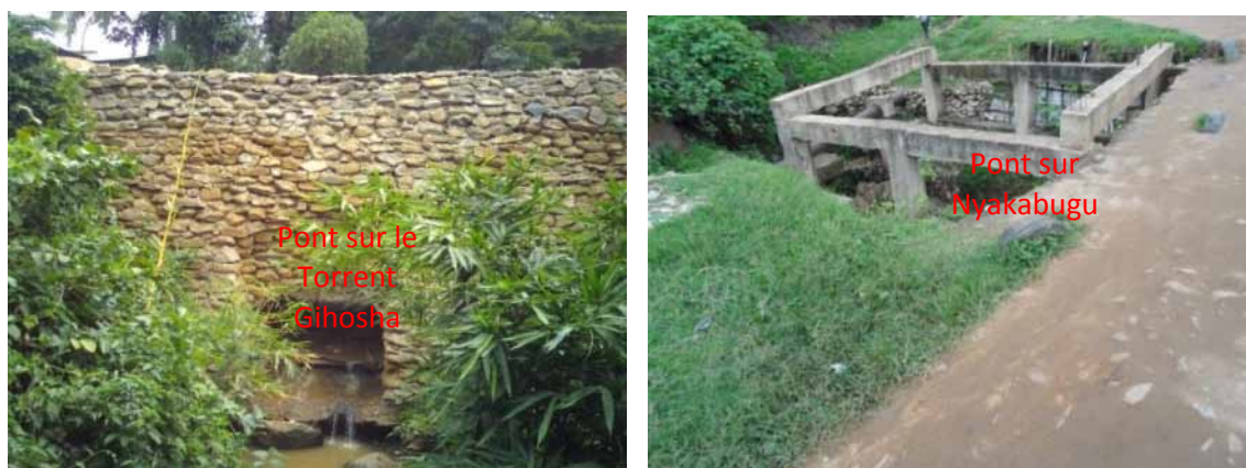
Photo 28: Des ponts en cours de construction par les habitants (Source : Cliché auteur, Photo prise le 08/12/2021)
