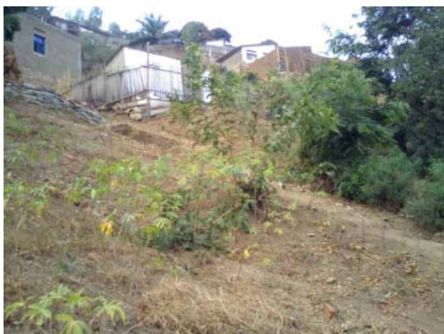
Photo 1: Des maisons vulnérables érigées sur une forte pente sur le flanc de la colline (Source : Cliché Auteur, le22/08/2021)
