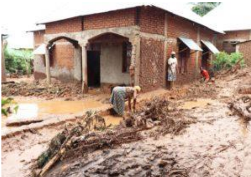
Photo 21 : Destruction des maisons par les inondations de Cari (Source : Journal Burundi Eco, photo prise le 23/12/2019)
