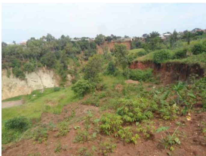
Photo 4: Glissement des berges du torrent Nyenzari à Gihosha rural (Source : cliché auteur. photos prise le 08/01/2022)
