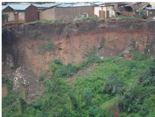
Photo 37 : Les menaces du torrent Nyenzari au quartier Gihosha rural (Source : Cliché Auteur, photo prise le 08/01/2022)
