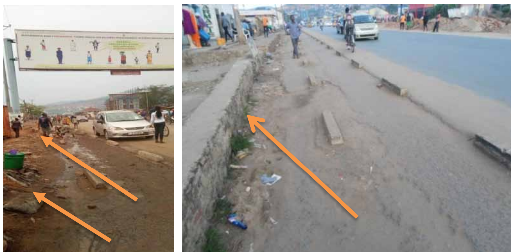
Photo 39 : Une digue de protection contre l'inondation du quartier Mirango (Source : Cliché Auteur ; photo prise le 15/10/2021)
