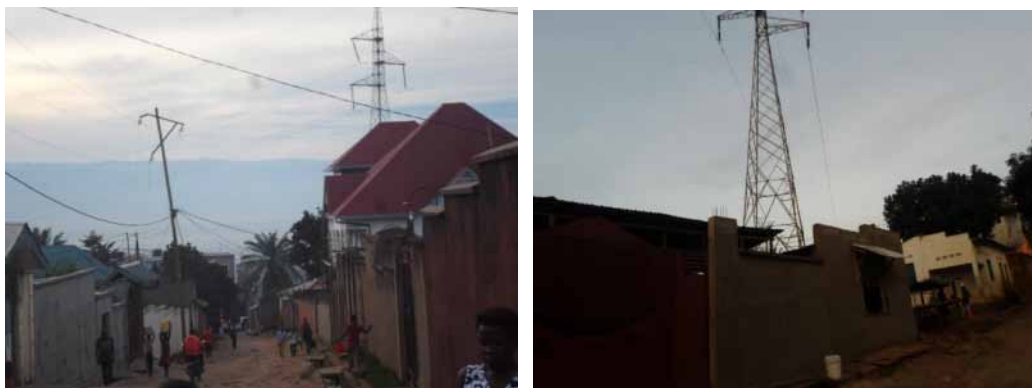
Photo 42 : Des lignes électriques haute tension au milieu des habitations (Source : Cliché Auteur, photo prise le 22/12/2021)
