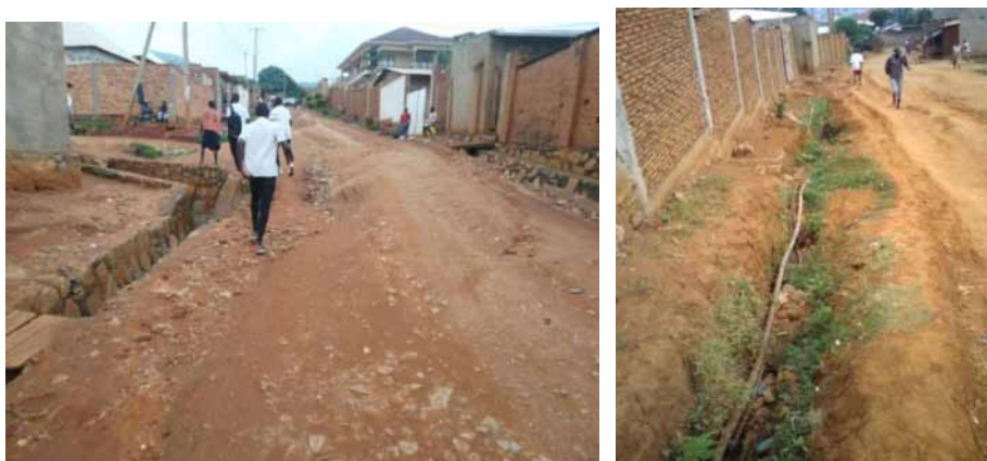
Photo 13 : Route tracée suivant la ligne de la plus grande pente à Winterekwa (Source : Cliché Auteur ; Photo prise le 09/12/2021)
