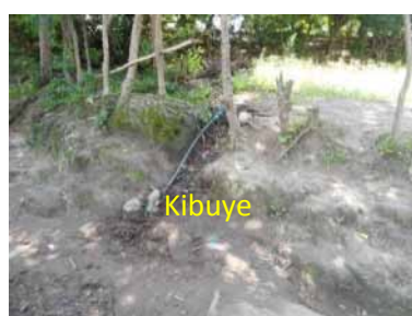
Photo 31: Passage des tuyaux d'eau à ciel ouvert à Winterekwa et à Rweza- Kibuye (Source : Cliché Auteur Auteur ; Photo prise le 08/12/2021)
