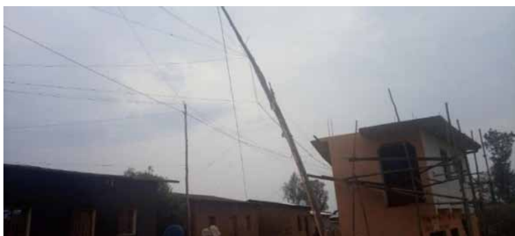
Photo 32 : Transport de Courant très risqué à Sororezo (Source : Cliché Auteur ; Photoprisele21/08/2021)
