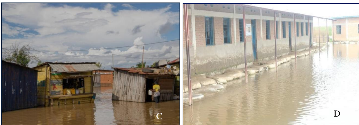
Figure 49: Faiblesse et ou absence des ouvrages de protection de l'école de Kinyinya II et des maisons à l'intérieur du Quartier, mars 2021 . Source: Iwacu, 2021
