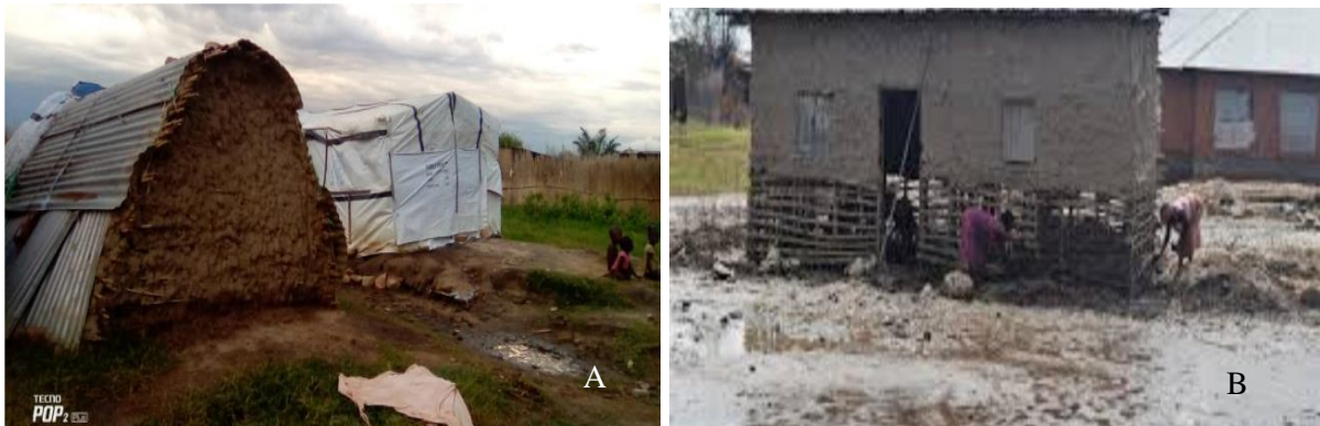
Figure 48: L'inadéquation des matériaux de Construction et mesures de protection inefficaces à Muyange II
