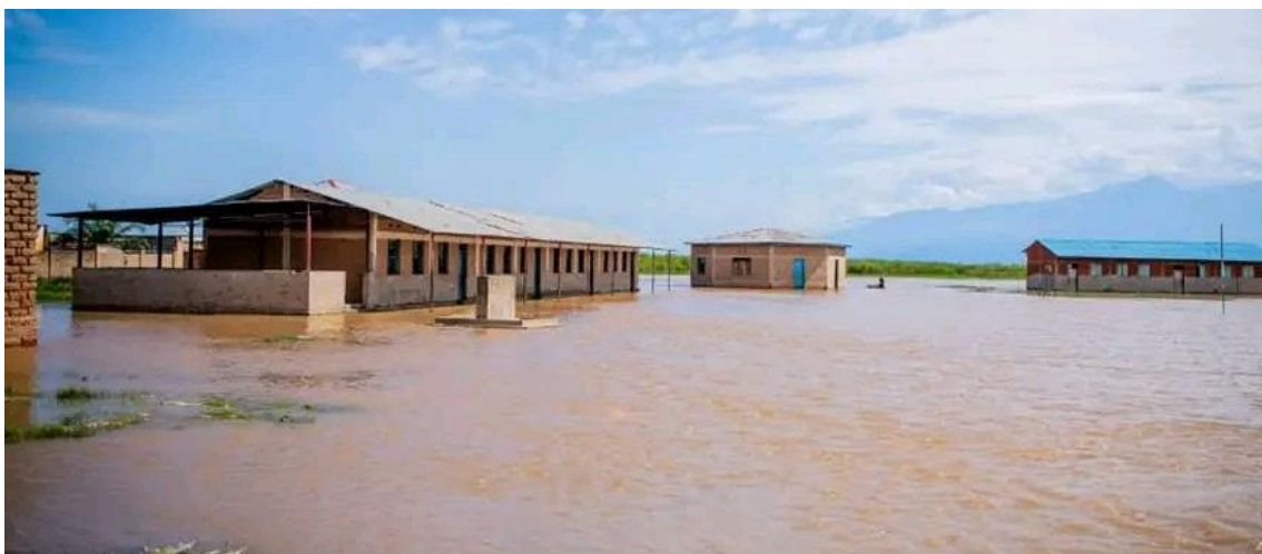
Figure 33: La cour de l'école primaire Kinyinya II submergée par des eaux provenant du lac Tanganyika, avril 2023.
