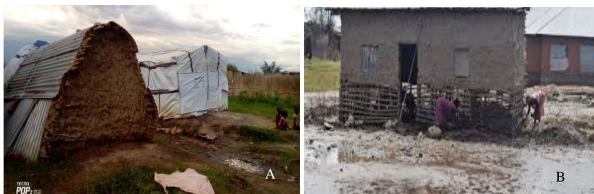
Figure 48: L'inadéquation des matériaux de Construction et mesures de protection inefficaces à Muyange II
