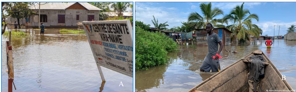
Figure 34: Les eaux du lac Tanganyika et de la rivière Rusizi ont envahi avec une hauteur élevée l'ensemble des quartiers de Gatumba 1 (OCHA, 2020).
