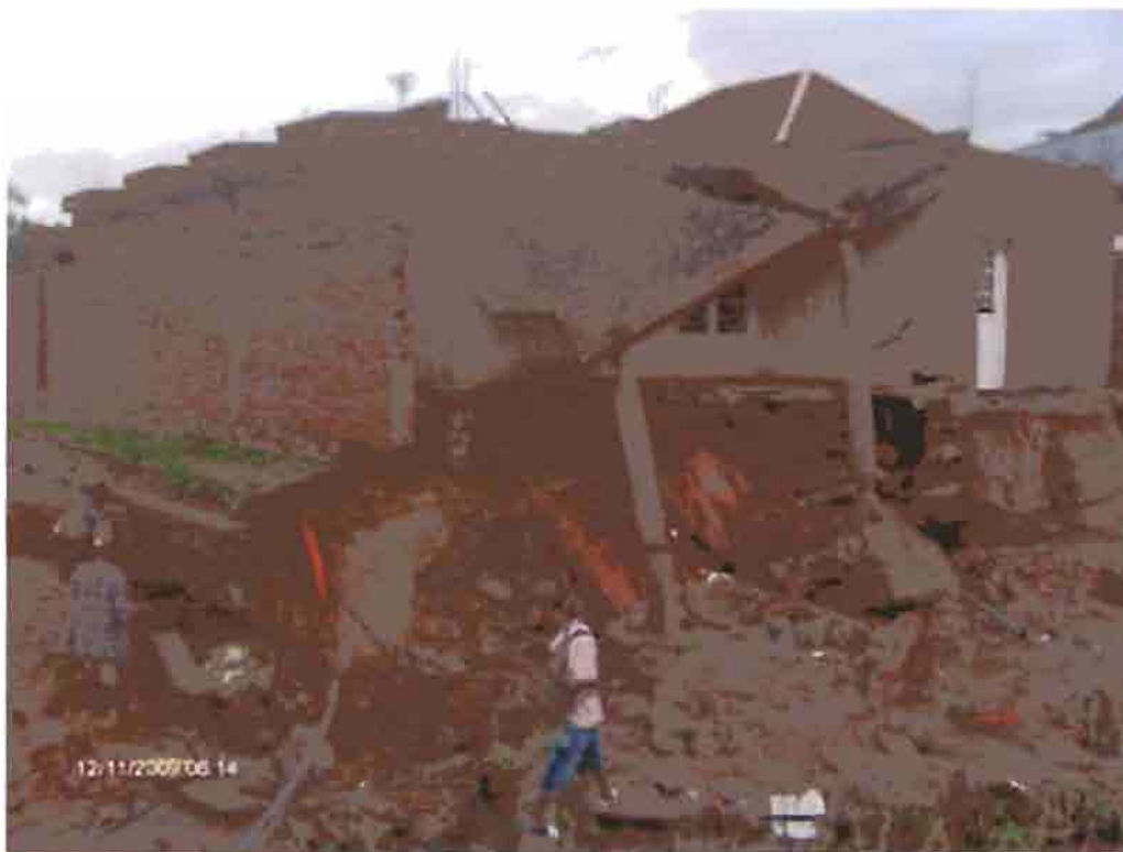
Photo 2: Effondrement d'une Maison après la rupture d'un ouvrage (cliché
