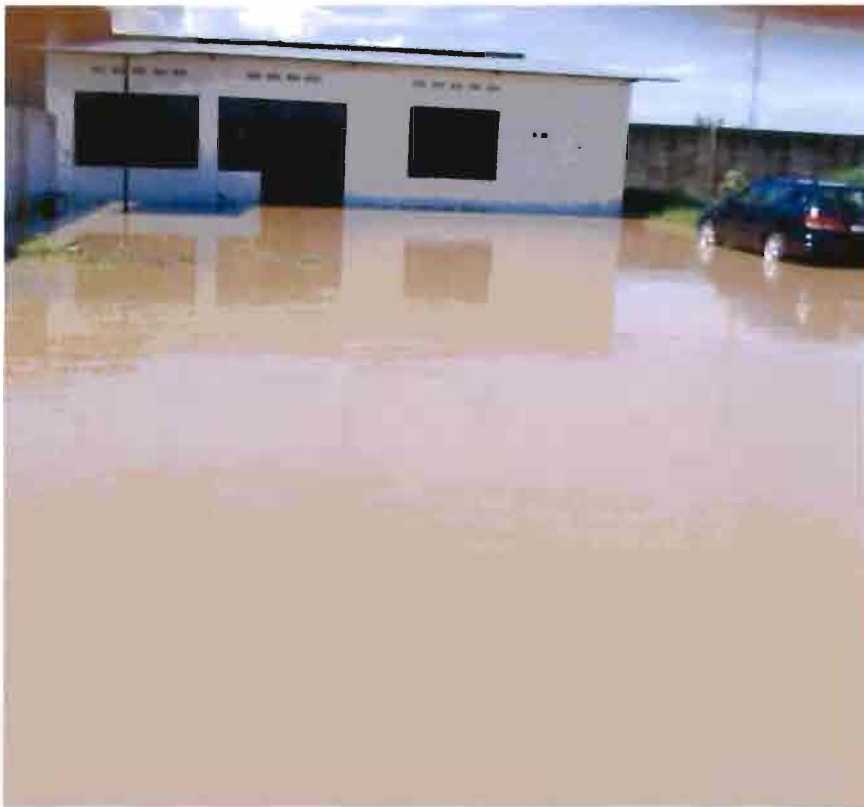
Photo10: Inaccessibilité dans les habitations au quartier industriel (Cliché SABUSHIMIKE.J.M, 2009)
