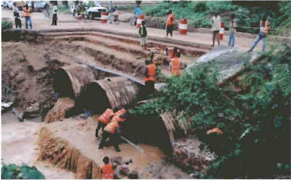
Photo11: Destruction du pont Muha suite à l'action de pluie (Cliché: Journal IWACU, 2010)
