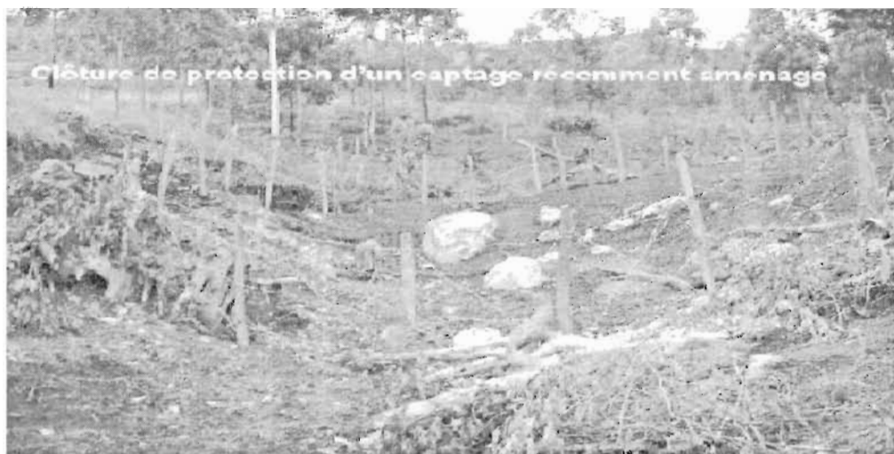
Photo 4 : Protection de la zone d'un captage
