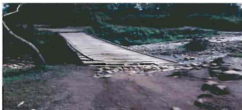
Photo n° 14: Pont construit par l'église de Gishiha
