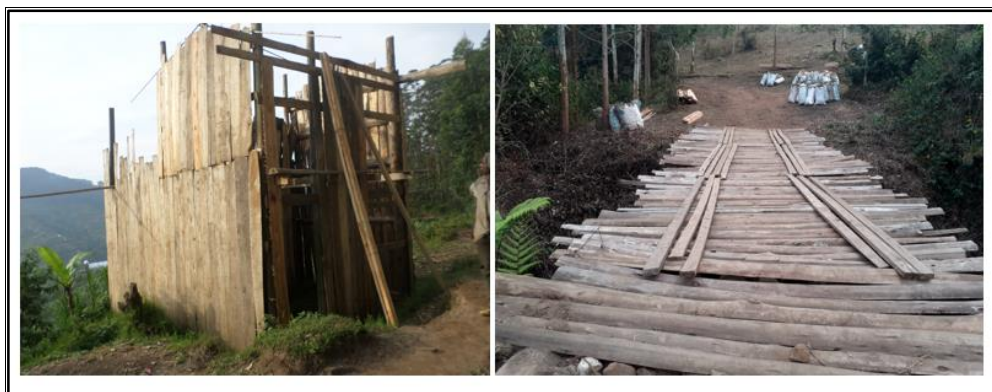
Photos 16 : (A) Kiosque sur la colline Kizuga et (B) un pont construits à l'aide des planches d'eucalyptus sur la colline Janda
