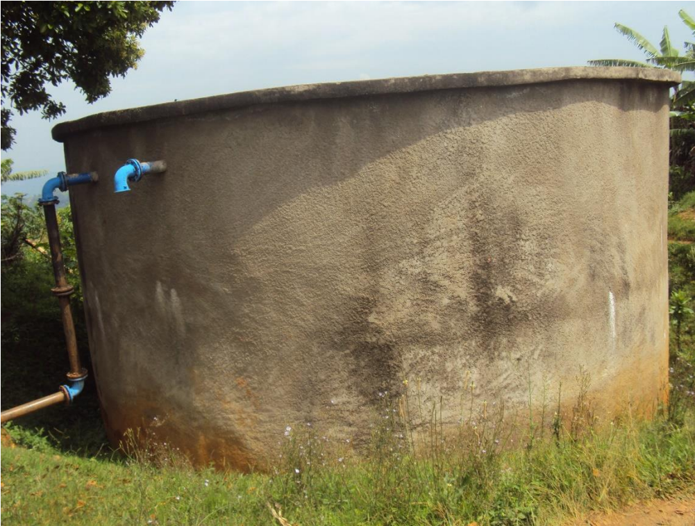
Photo 15: Réservoir maçonnerie qui collecte le débit des sources de TEZA
