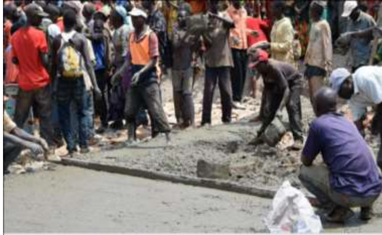
Figure 1. 5 - Photo prise au Burundi en date du 25 juin 2021 montrant un des moments du bétonnage d'un dallage du sol.
