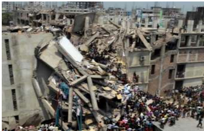
Figure 1.11 – Effondrement d’un immeuble en cours de construction à Bangladesh.
