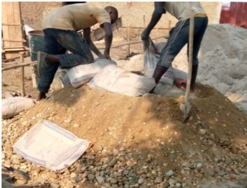
Figure 1.8 – Photo prise en date du 26 juin 2021 au Burundi illustrant l'étape du mélange des constituants d'un futur béton.
