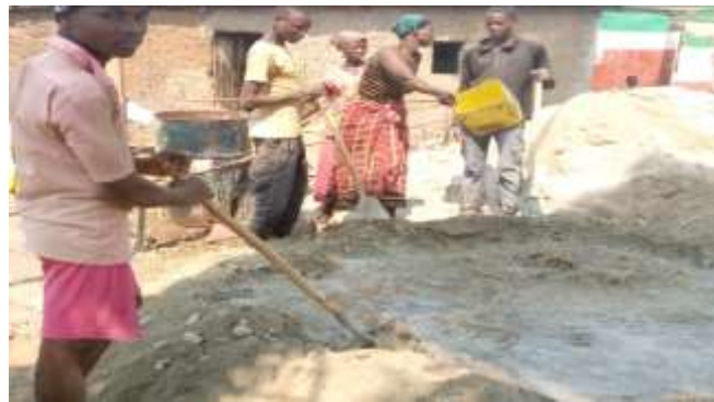
Figure 1.3 – Photo prise en date du 26 juin 2021 montrant l'étape de malaxage du béton sur l'un des chantiers au Burundi.
