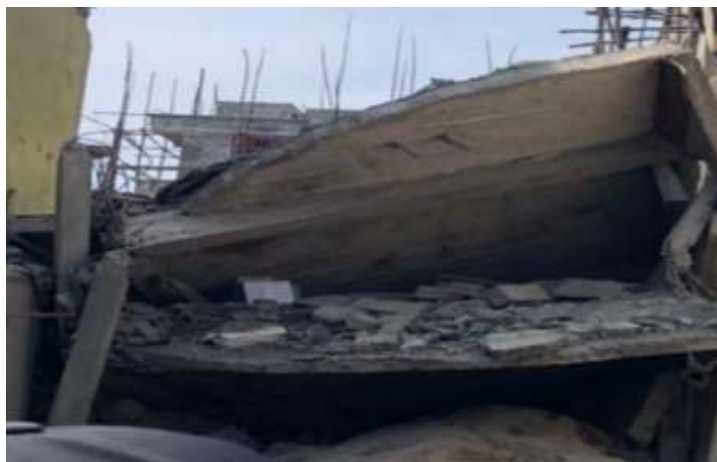
Figure 1.12 – Effondrement d’un immeuble en cours de construction à Kinshasa 26 octobre 2021.
