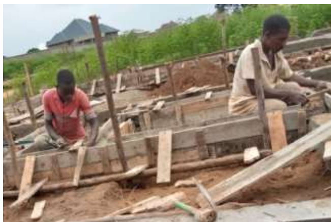
Figure 1.1 – Photo prise 12 mai 2021 illustrant l'exemple de coffrage en bois des chainages au Burundi.
