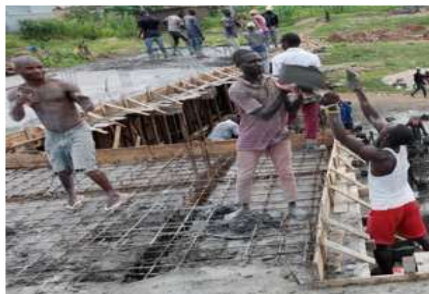
Figure 1.4 - Photo prise au Burundi en date du 28 juin 2021 montrant un des moments du bétonnage d'un plancher en béton armé.
