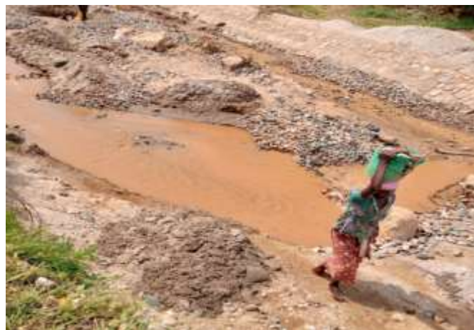
Figure 1.6 – Photo prise en date du 26 mai 2021 illustrant la rivière Gasenyi comme source des granulats et d'eau utilisés dans la réalisation du béton.
