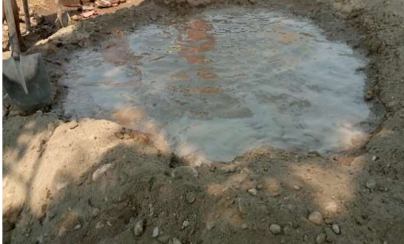
Figure 1.9 – Photo prise en date du 26 juin 2021 au Burundi illustrant l'étape de gâchage des constituants d'un futur béton.
