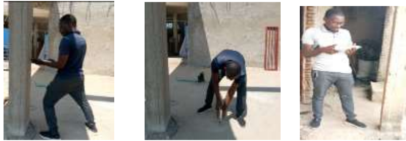
Figure 2.5 – Photos montrant l'exemple de mesurage de la dureté du béton pour l'ultérieure définition de la résistance en compression du béton.
