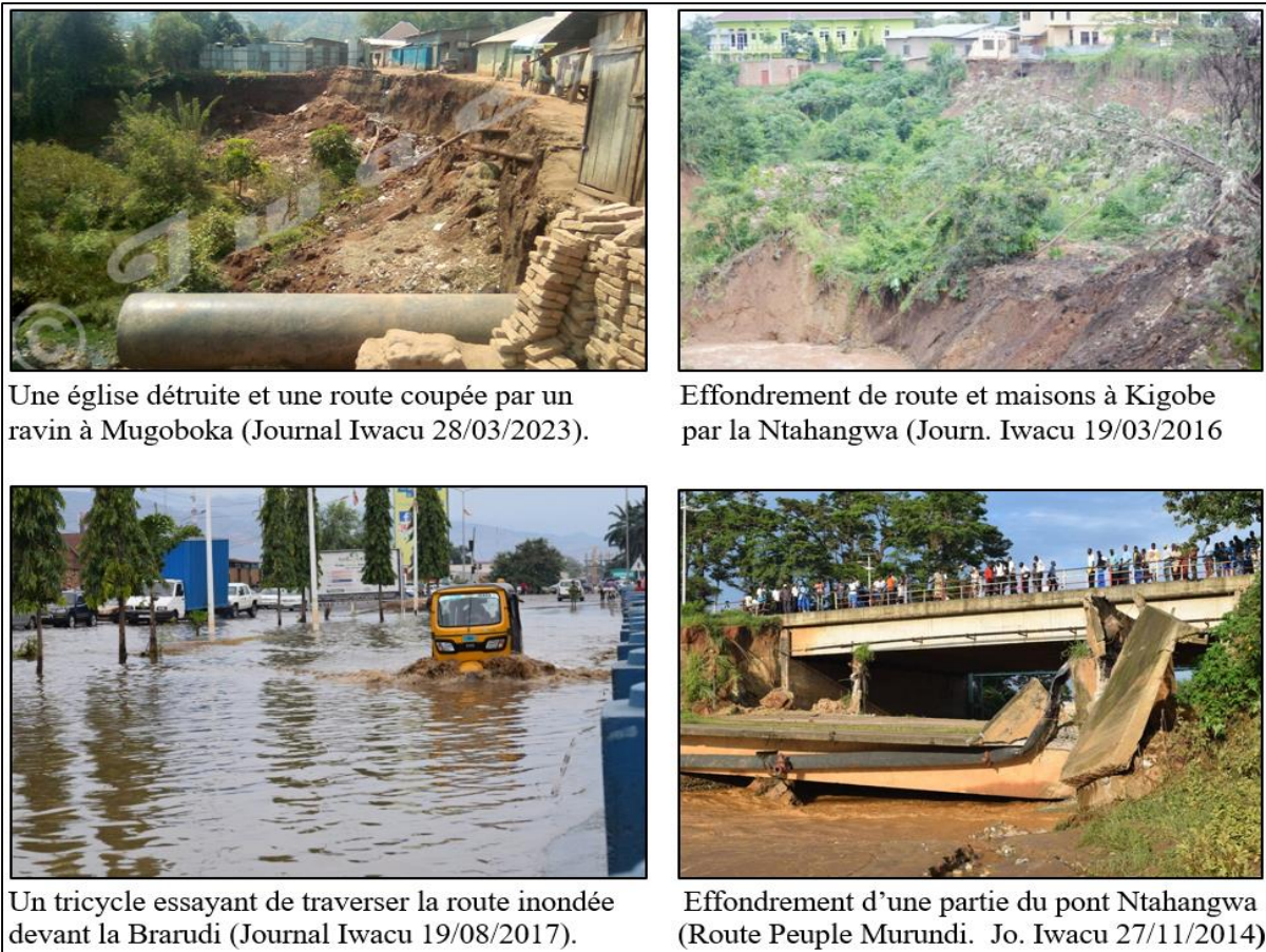
Figure 16: Nuisances dues aux crues de la rivière Ntakangwa suite à l'érosion de son BV.
