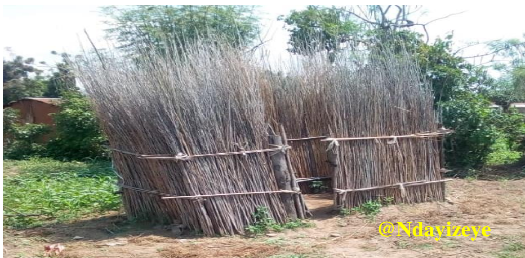
Photo 3.10 : Latrine construite en paille au centre urbain de Gatumba.
