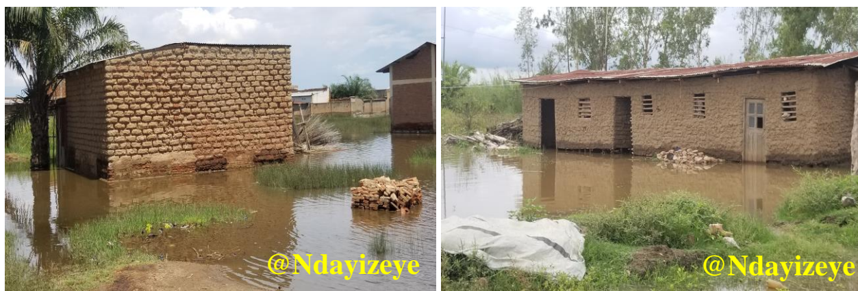
Photo 3.9 : Constructions anarchiques dans la zone Gatumba
