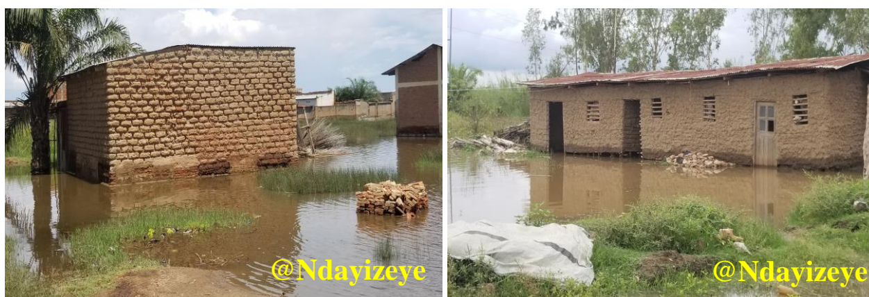
Photo 3.9 : Constructions anarchiques dans la zone Gatumba
