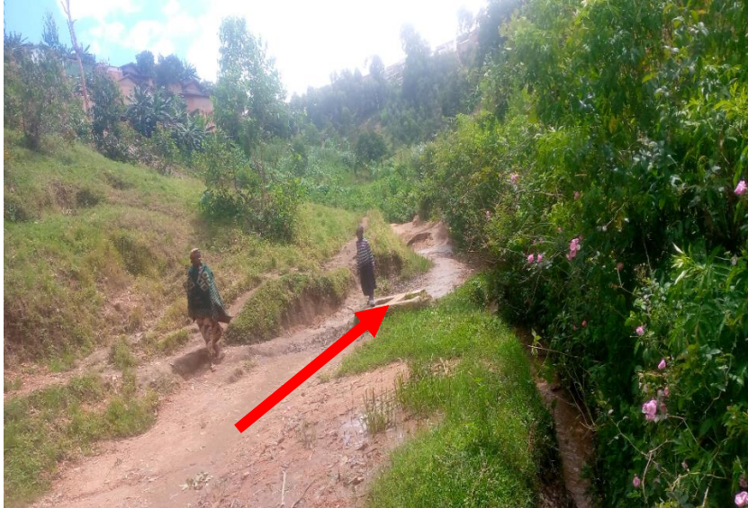
Photo 6: Destruction d'une borne fontaine par les eaux de ruissellement provenant du quartier Gatwaro et Swahili
