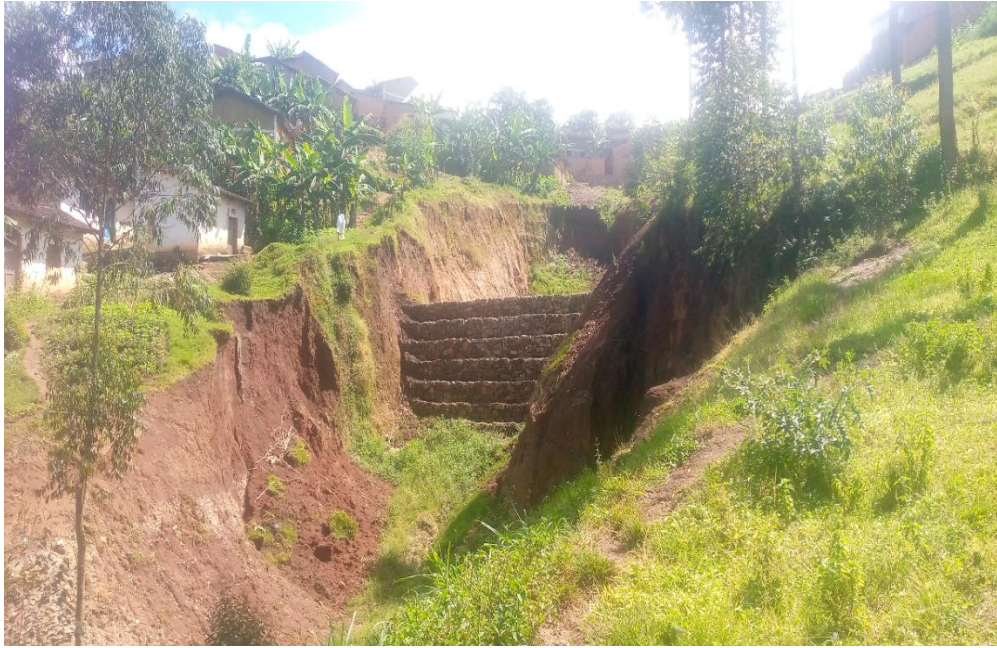
Photo 8: Des maisons à cote d'un grand ravin soumis au risque de glissement dans le quartier Swahili
