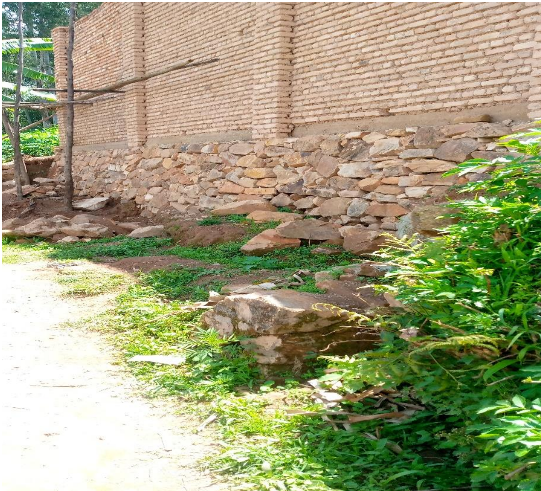
Photo 5: Fondation surélevée d'une maison dans la périphérie du quartier Mukoro
