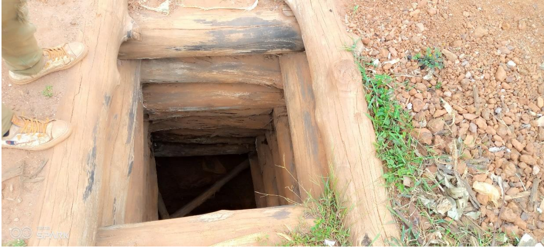
Figure 5: Soutènement d'un puit sur le site de Nyarubuye kw'ishonga
