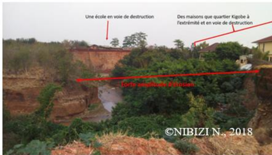
Figure 13: Glissements des berges de la rivière Ntakangwa au quartier Kigobe. Photo Nibizi, le 24 août 2018
