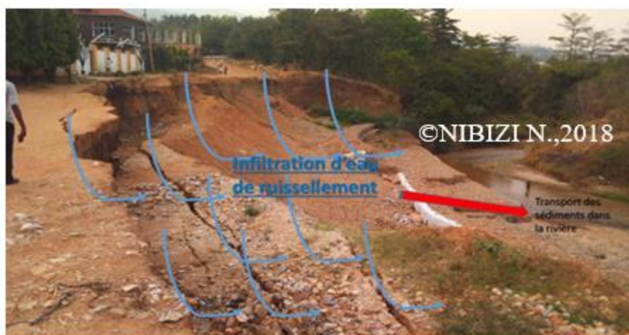
Figure 12: Fissurations dues aux écoulements hypodermiques, érosion latérale. Tentative échouée de stabilisation. Photo Nibizi, le 24 août 2018
