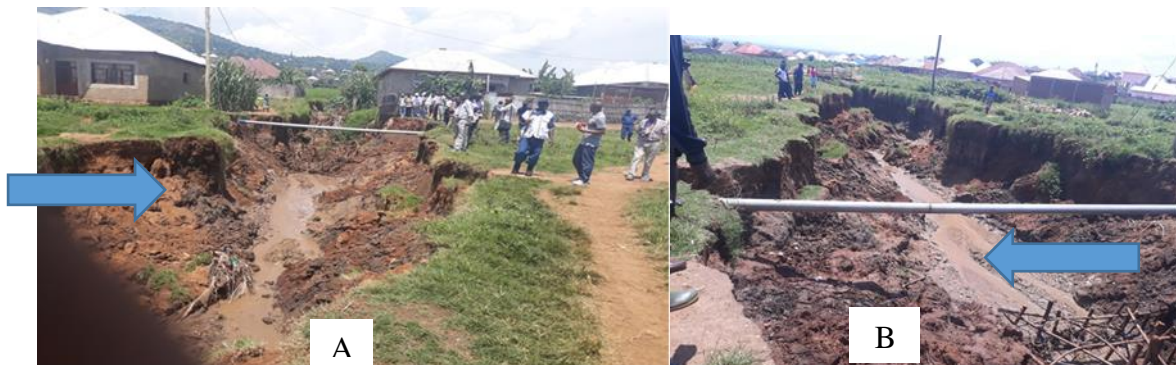
Figure 5: Conséquences de l'éboulement des berges du ravin Nyamanogo. Photo Sabushimike, le 21 Avril 2005
