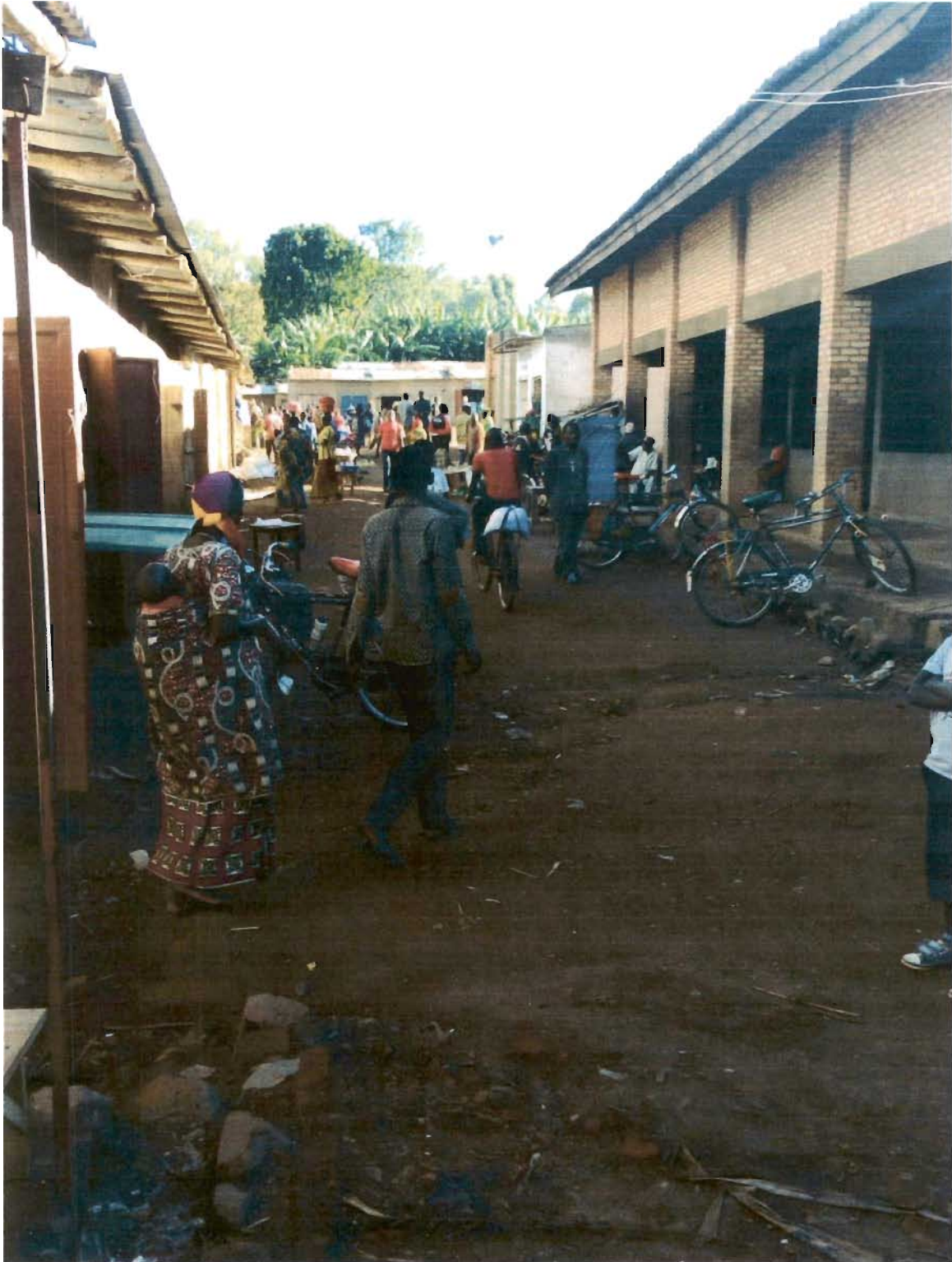
Photo n°1 : La façade avant du marché de Muriza
