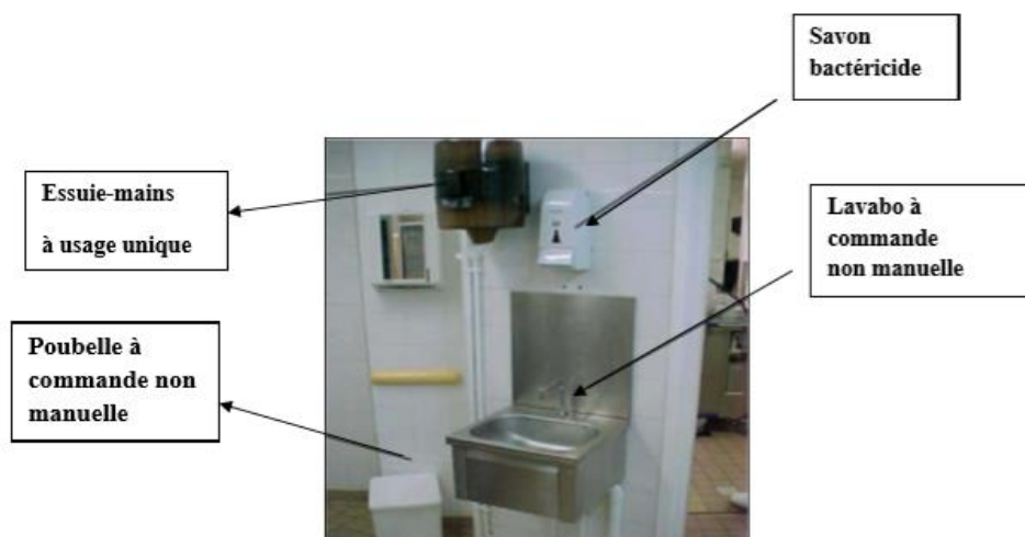
Figure 3: Un dispositif pour le lavage et le séchage hygiénique des mains (Anonyme 5, 2009)
