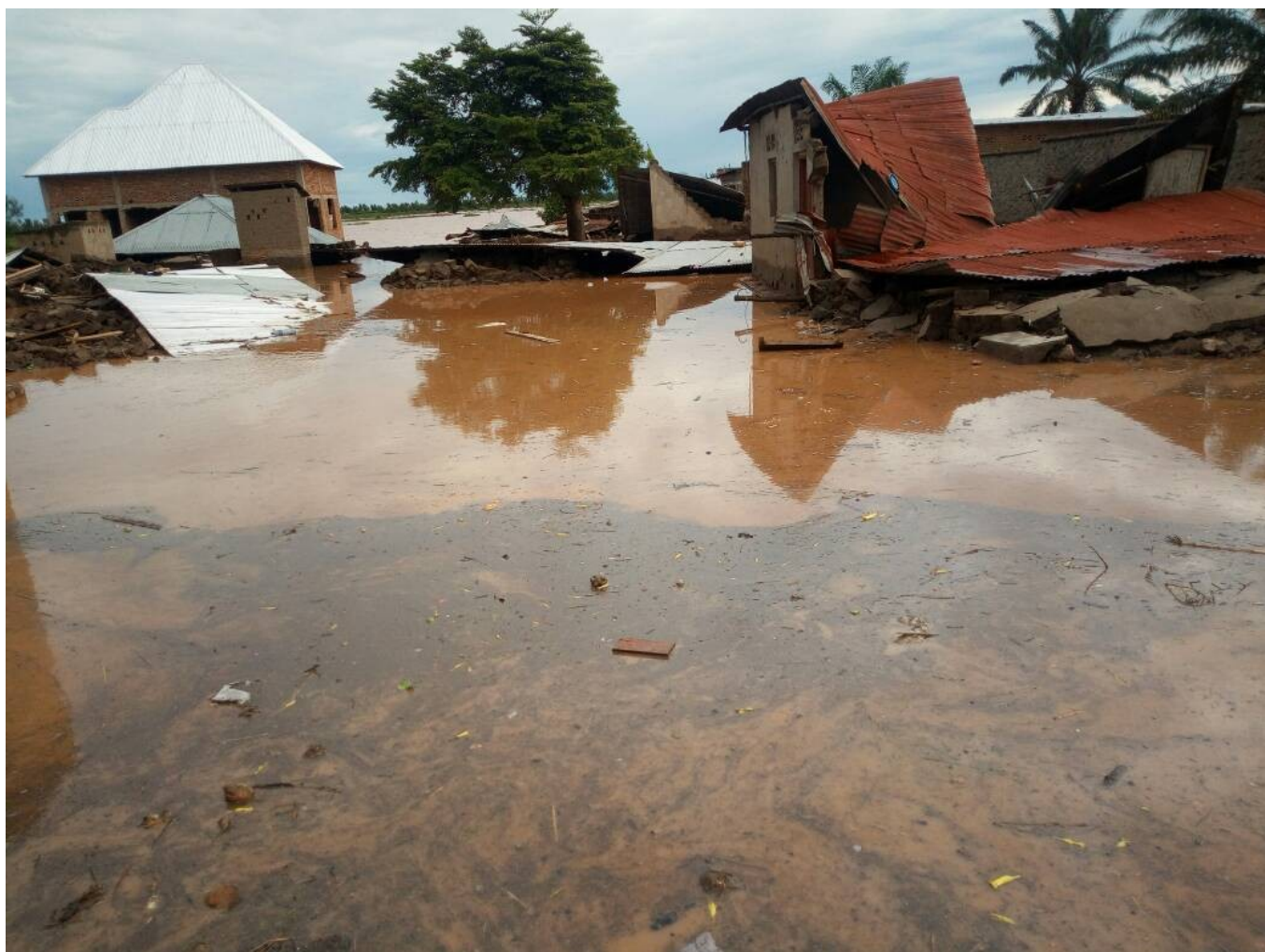
Photo 5 : Inondation à KiyangeII (Photo, Auteur, le 28/4/2018)
