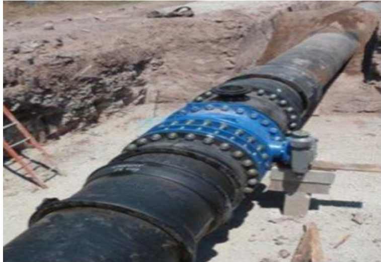
Figure II.6-1: Conduite de transport d'AEP
