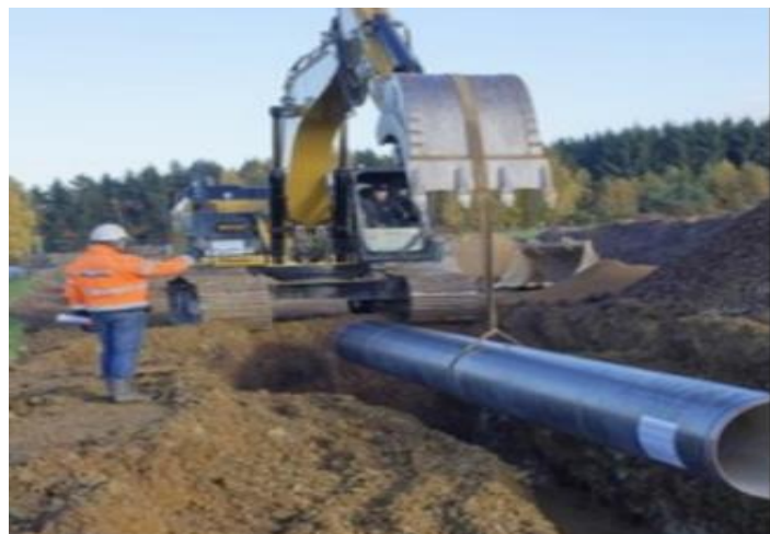
Figure II.6-2: Pose de la conduite de transport d'AEP
