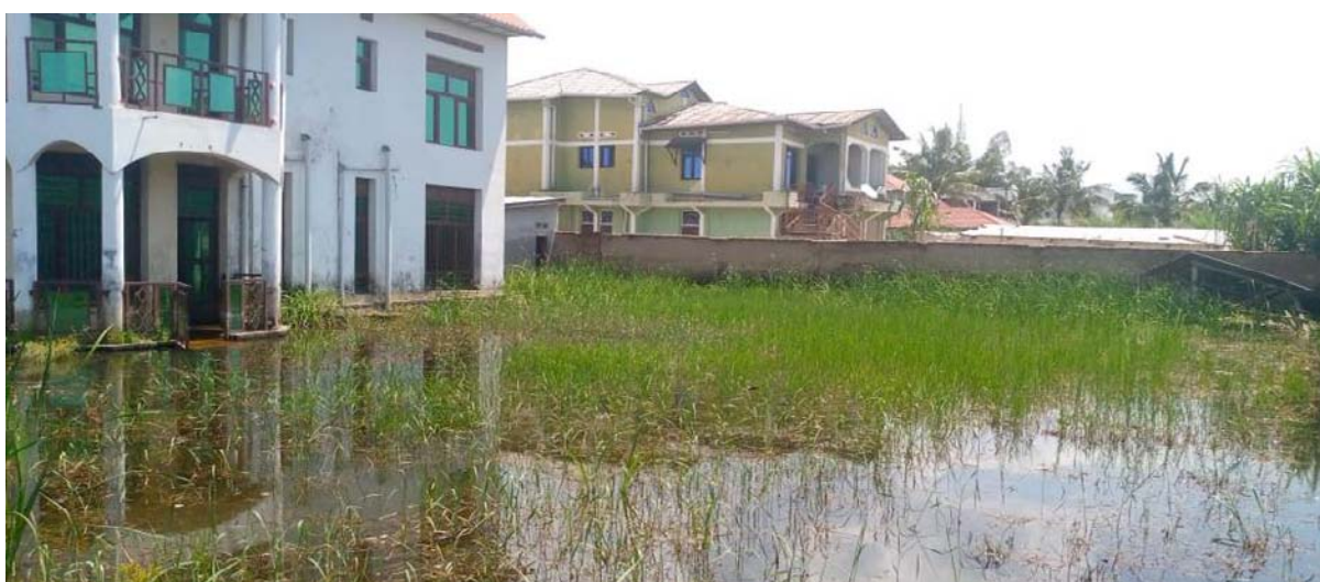
Photo III. 17 : Maisons inondées et abandonnées à Kabondo (2) (cliché, Auteur, Novembre 2023)
