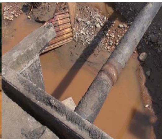
Photo III.7 : Destruction des réseaux de distribution d'eau à Kamenge (PNPRGC, 2014)
