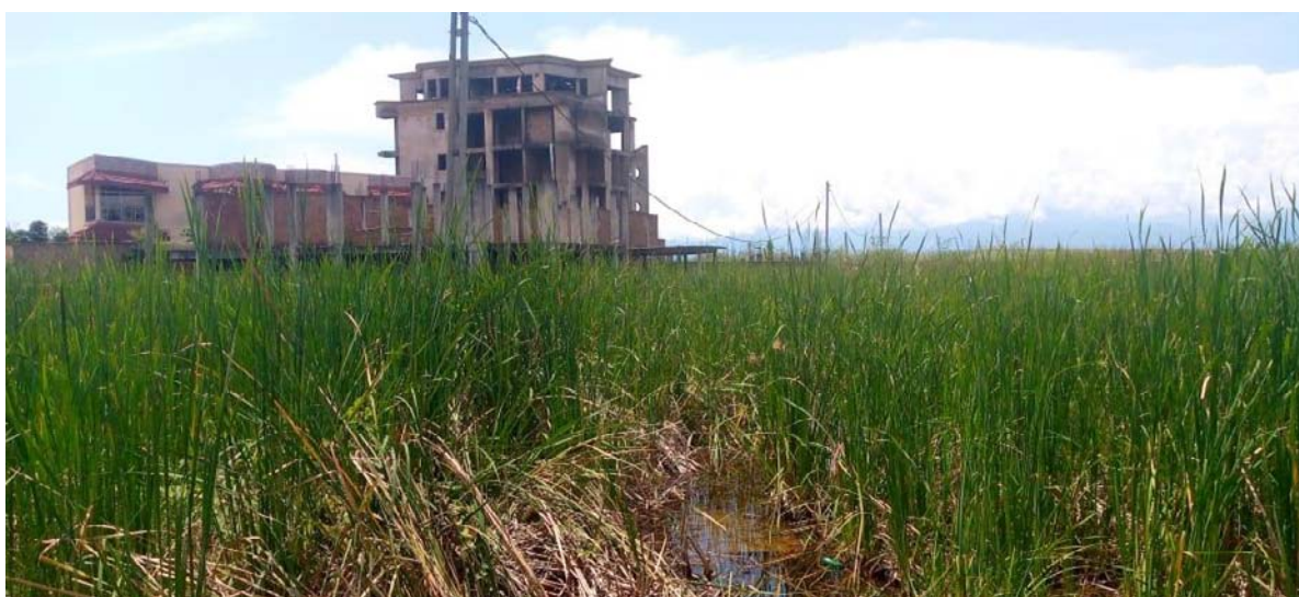
Photo III. 16 : Maisons inondées et abandonnées à Kabondo (1) : (cliché, Auteur, Novembre 2023)
