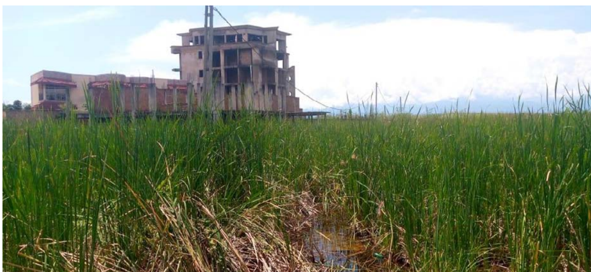
Photo III. 16 : Maisons inondées et abandonnées à Kabondo (1) : (cliché, Auteur, Novembre 2023)
