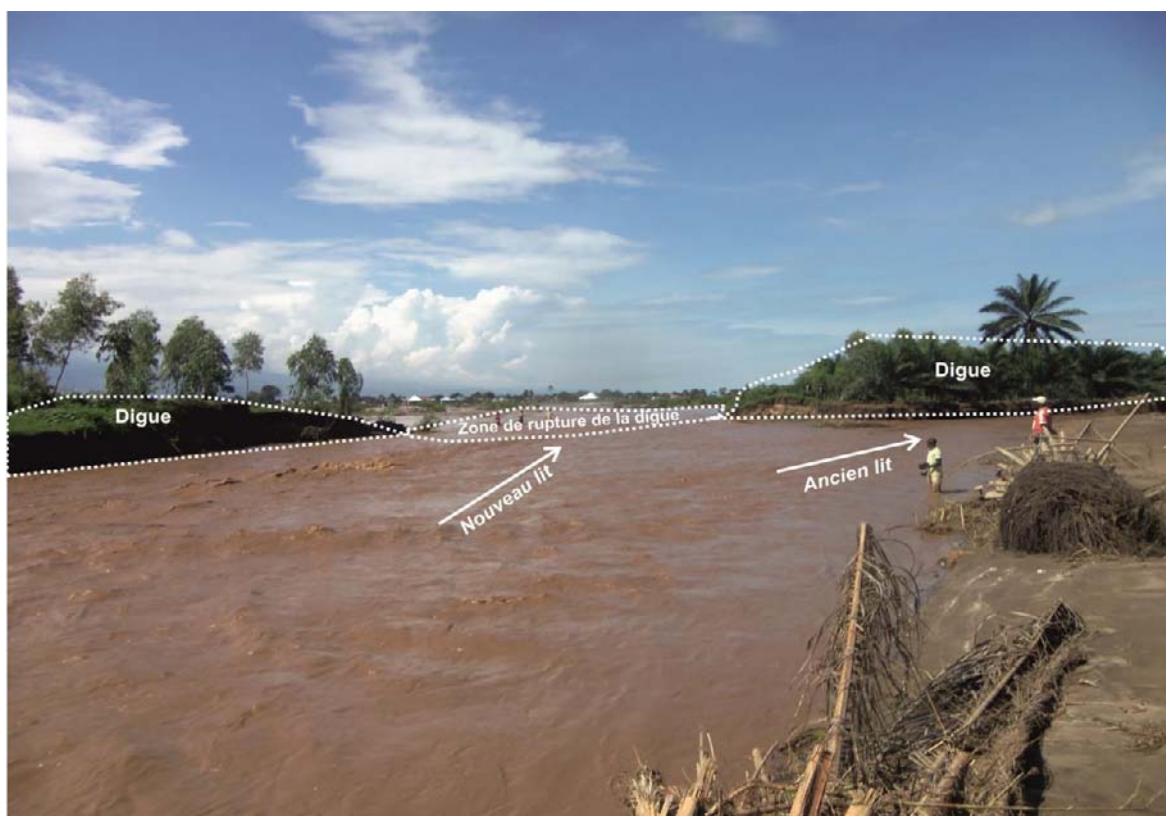
Photo III.11 : Rupture de la digue sur la rivière Mutimbuzi en 2018 (SINDAYIHEBURA, 29 avril 2018)
