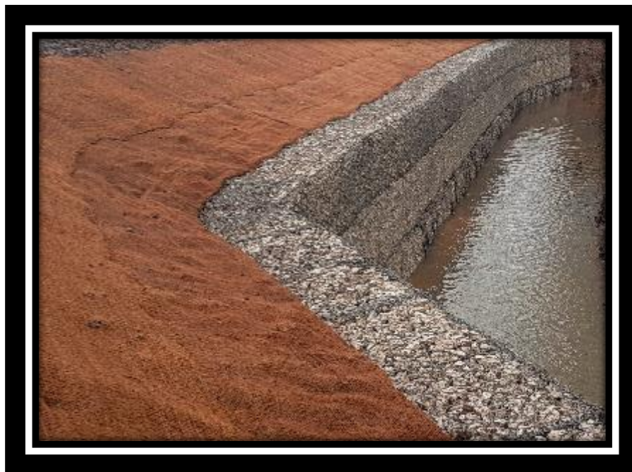
Figure 19: Stabilisation par le gabionnage
