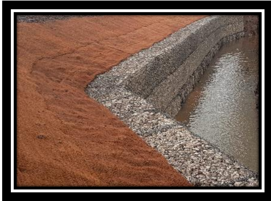
Figure 19: Stabilisation par le gabionnage
