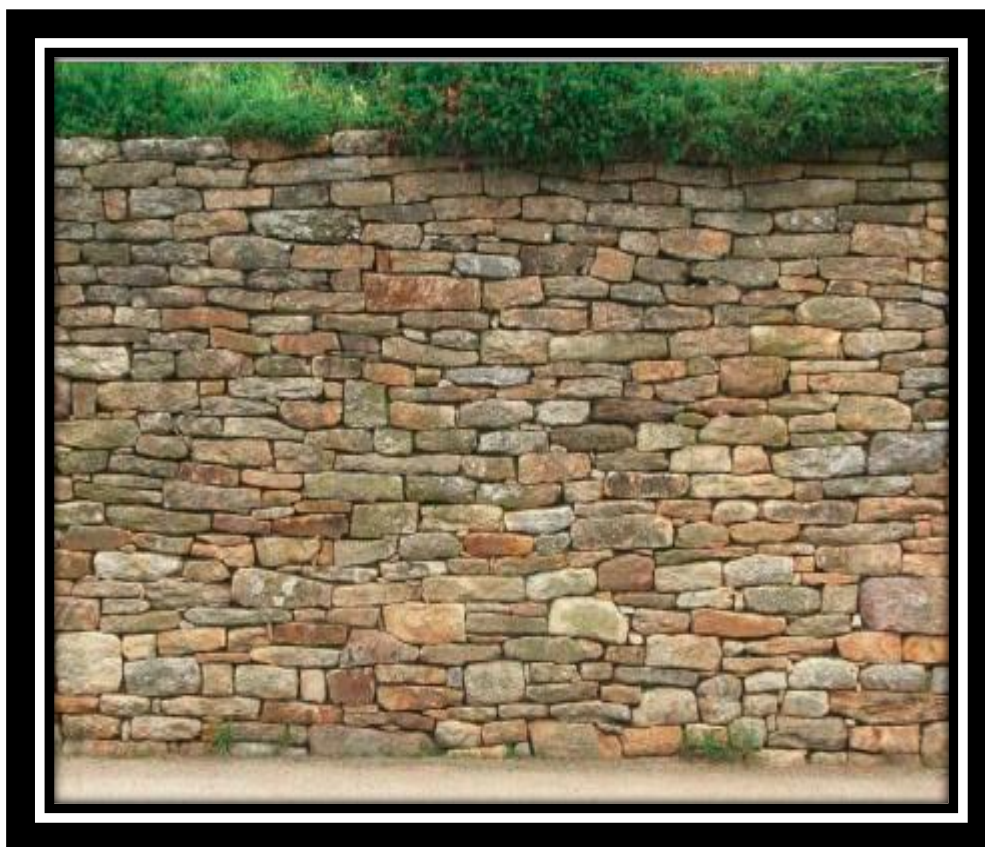
Figure 22 : Berge maçonnée et radier en enrochement
