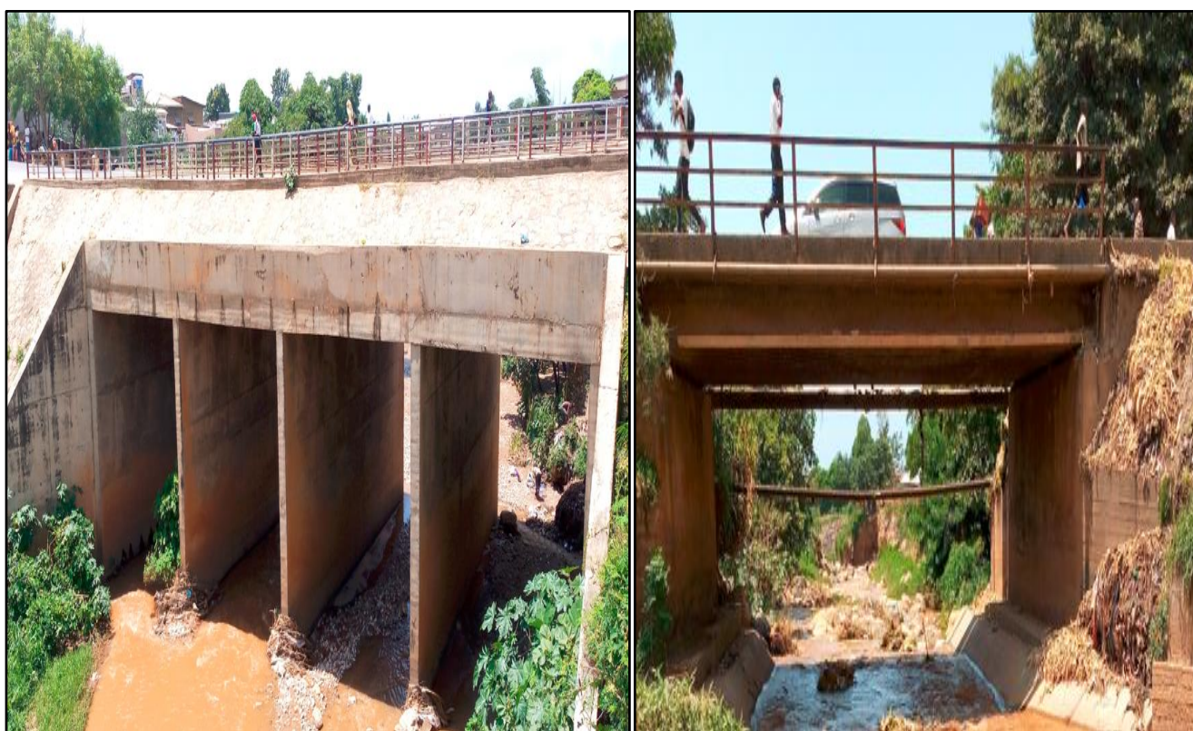
Pont KANYOSHA sur la douzième avenue (a)
