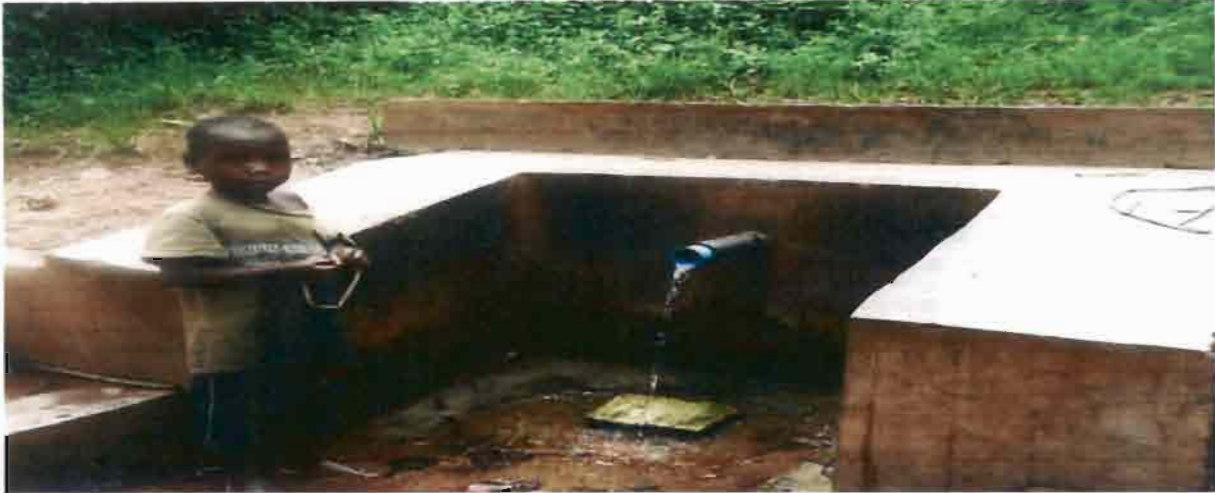
Figure I.2 : Source d'eau aménagée sur la colline NYABUGENI
