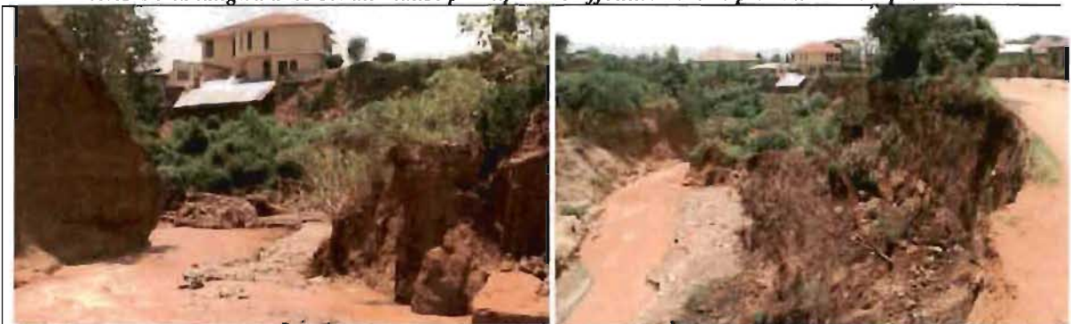
Figure 43 et 44' : Photos illustrant les glissements produits en aval du chassée 28 novembre donc la cause principale est la suppression de la butée de pied de la berge.
