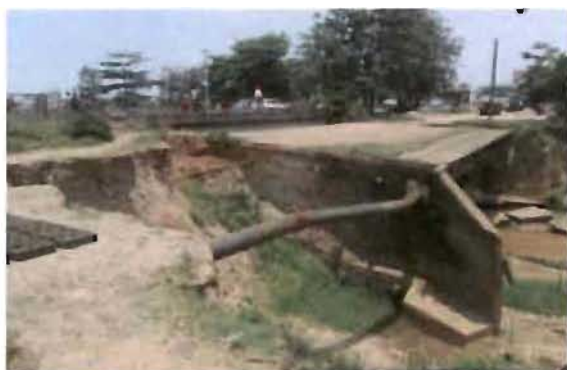
Figure 4 : destruction de l'ancien pont de la chaussée du Peuple MURUNDI
