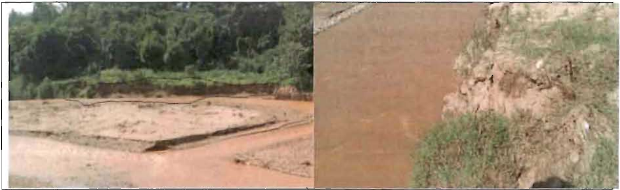
Figure 41 et 42' : (illustration des berges situées en amont du pont chaussée peuple Murundi).
