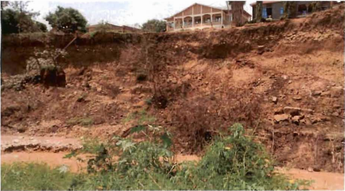
Figure 10 : glissement de la berge de la Ntchangwa ayant emporté une partie de la route KIGOBE et menaçant ainsi les maisons qui se trouvent à proximité.
