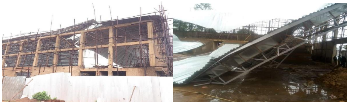
Figure 8 : Charpentes des structures détruites par le vent en (a) et (b) : Envolement et endommagement de la toiture de la tribune du stade de basketball à Gitega)
