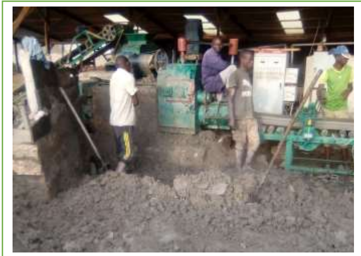
Photo 1: Fabrication des briques étirées (source: photo prise sur le site Buringa)
