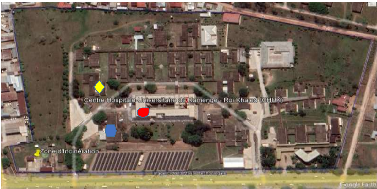
Figure 9: Photographie du Centre Hospitalo-Universitaire de KAMENGE
