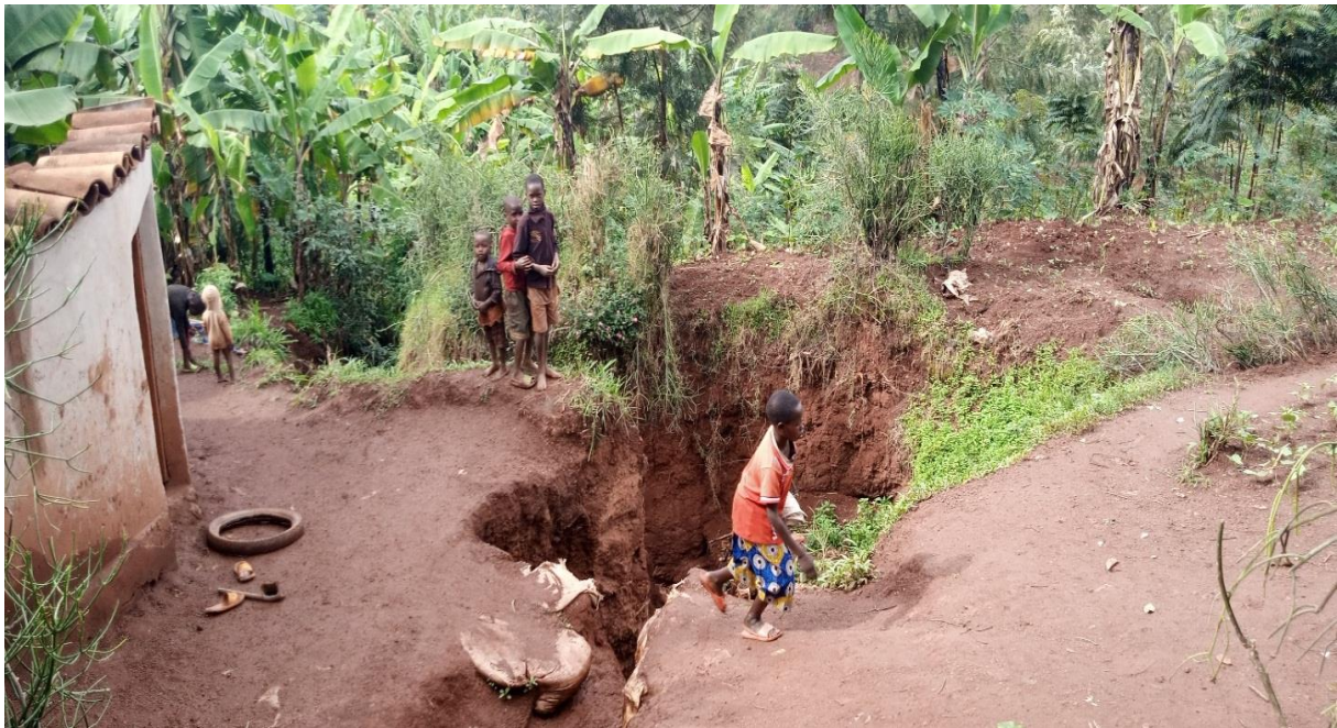
Photo 10 : Risque d'accident aux humains
