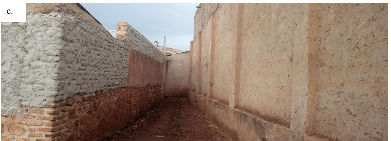
Photo 6,7et 8 : Construction spontanée à Kinyota
