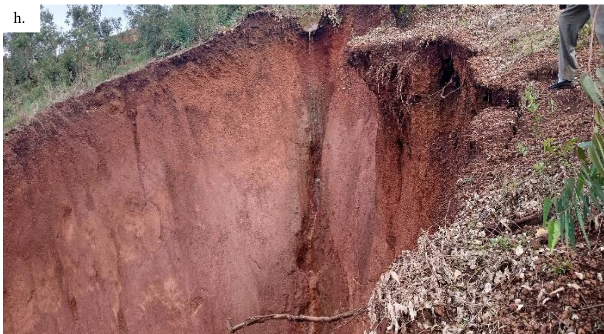
Photo 9 : Création des ravins par des eaux de ruissellement en quartier Swahili.
