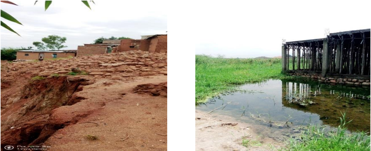
Figure 12: Constructions anarchiques des maisons à Bujumbura (Ndayihimbaze,2020)
