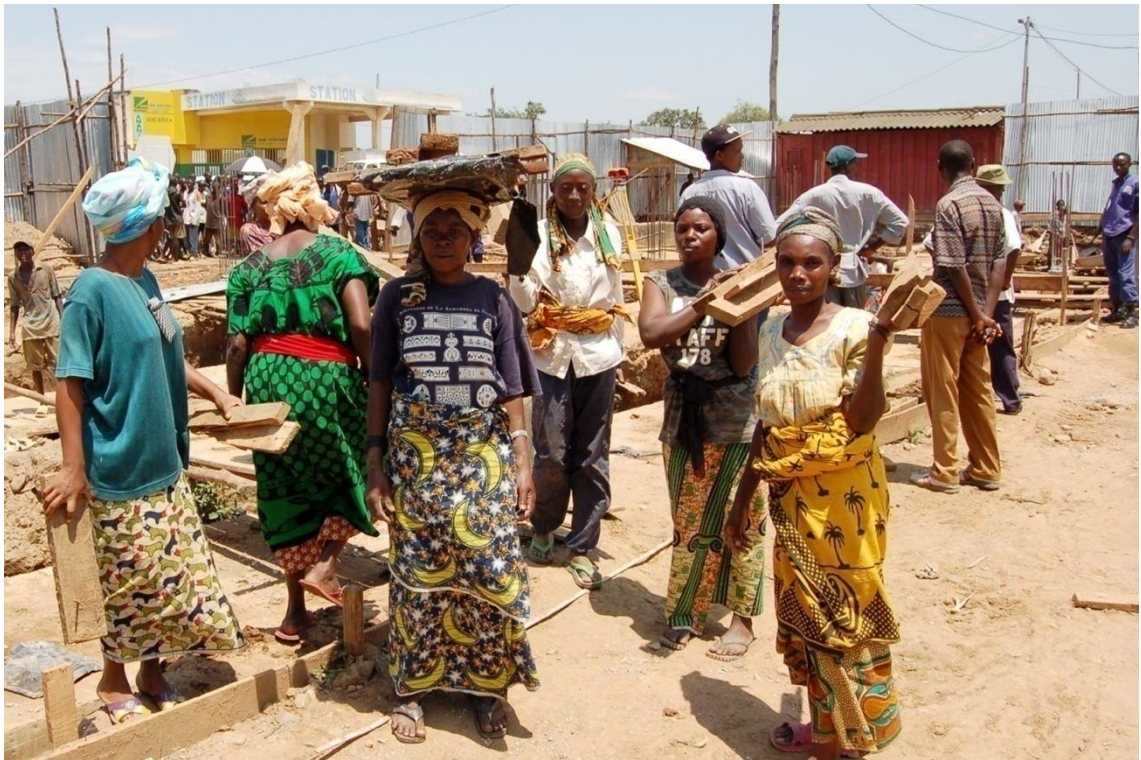
Photo 2 : Femmes aides-maçons sur le chantier de construction du marché de Buyenzi
