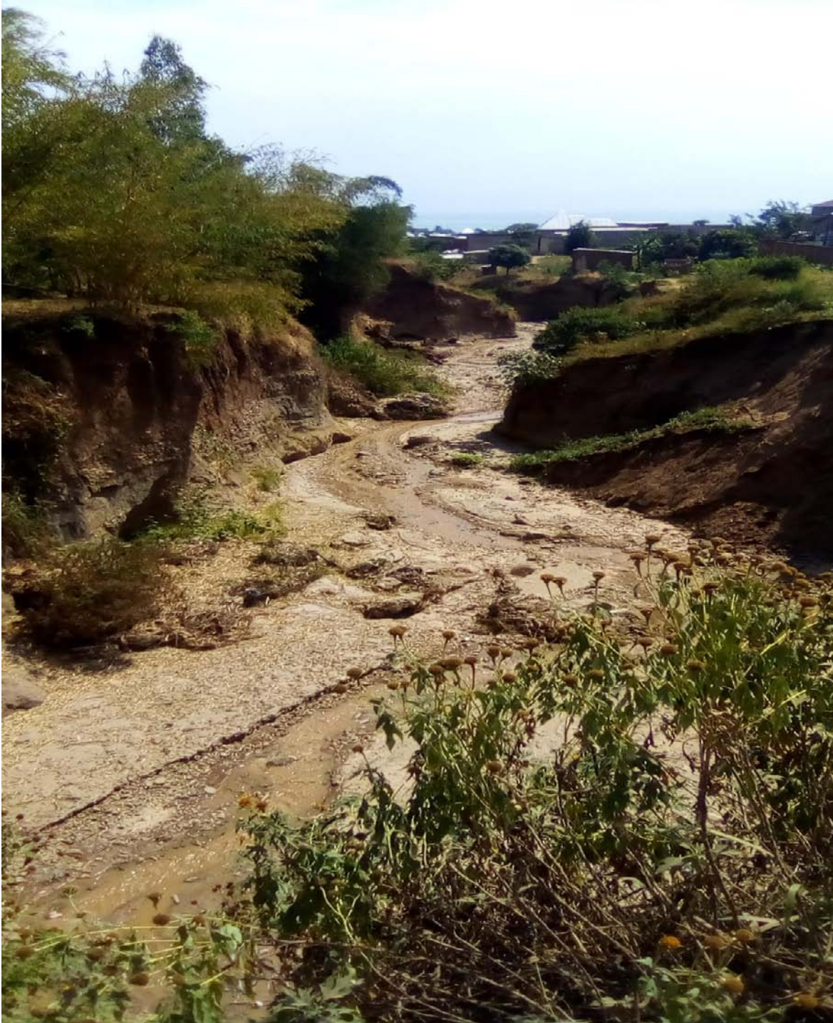
Figure III-9 :photo (prise sur place) de l'état actuel de la rivière Kizingwe
