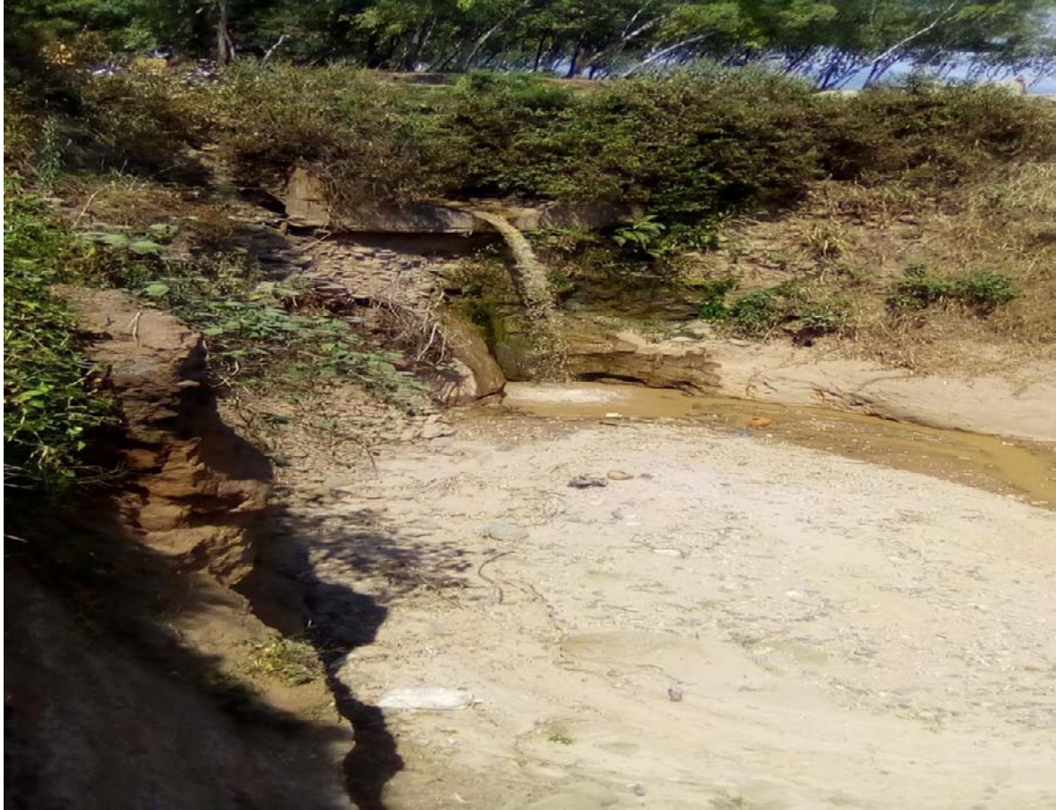
Figure III-8 : photo (prise sur place) de la chute en aval de la rivière Kizingwe sur le pont de la RN3.
