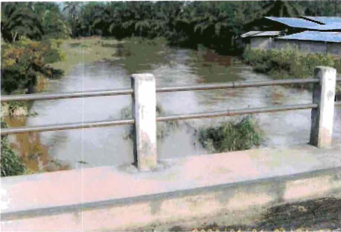
Fig. 19 : Rivière Murembwe en face de l’Huilerie.
