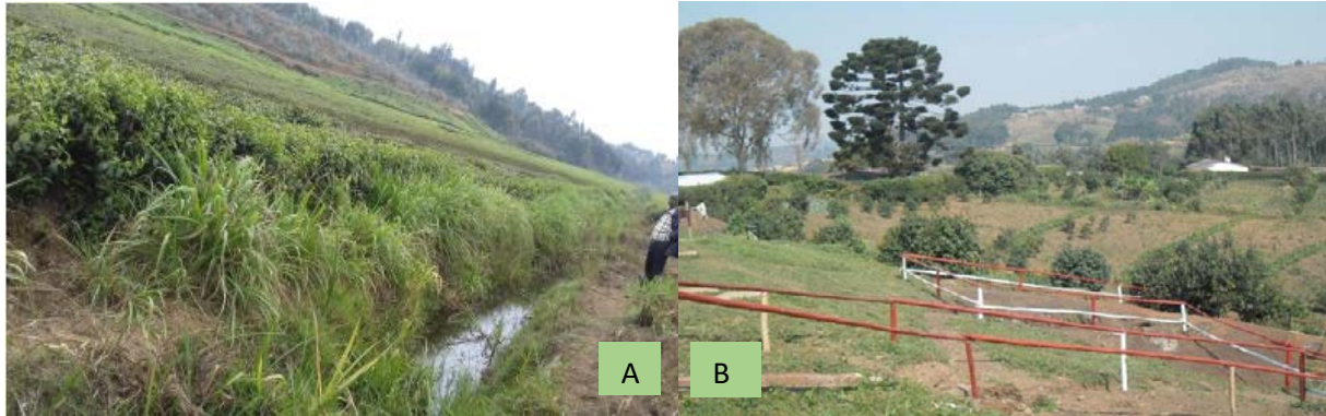
Figure 5 : Mesures de protection de l'environnement (A: protection des ruisseaux, B: Fosses de retenue des eaux de pluie)
