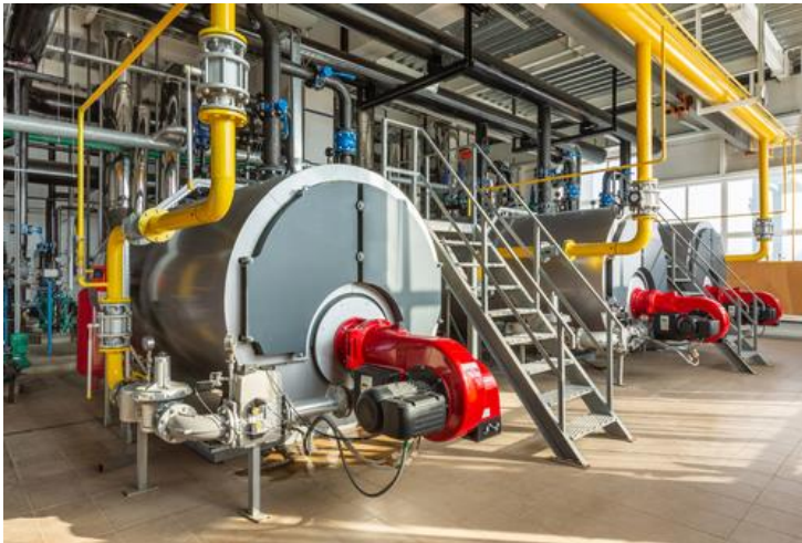
Figure 7: Chaudière électrique pouvant être utilisée dans les usines à thé (Sw) 3
