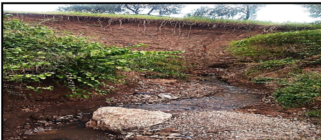
Photo 3.9 : Effondrement des berges de la rivière Nyabagere dans la zone Nyambuye
