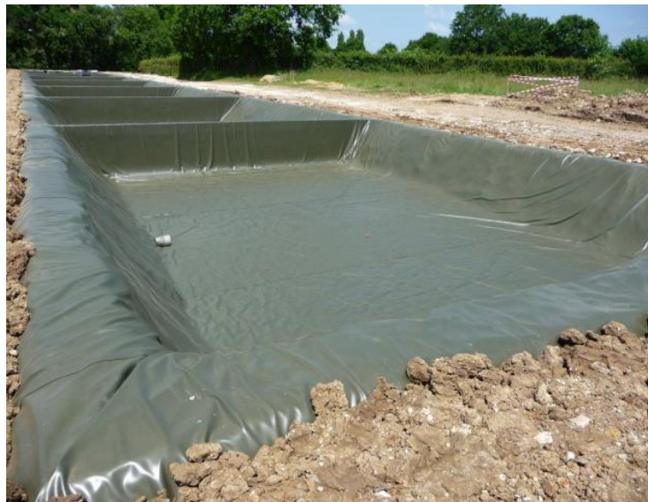
Figure 11: Exemple d'une photo du bassin de rétention avec étanchéité par géomembrane.
