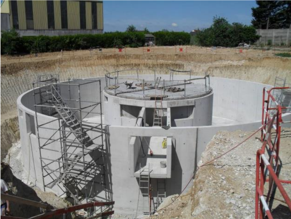
Figure 10: Exemple d'une photo du bassin de rétention en béton armé
