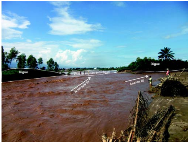
Photo 28 : Zone de la rupture de la digue située à 486.5mètres du pont Mutimbuzi
