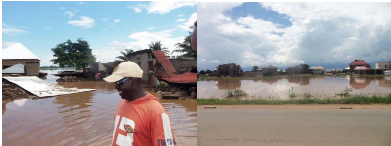
Photo 36 : Des maisons (en adobes) totalement effondrées situées près des rizières de Kiyange et des maisons en matériaux en dur du quartier miroir situées à l'Est de la RN5 sous l'eau.
