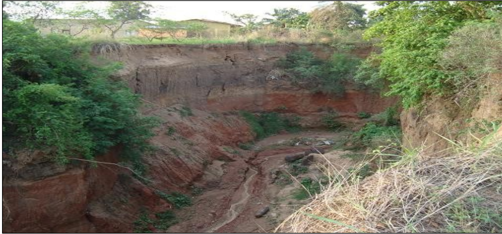
Photo 3 : Approfondissement du ravin de Kamesa
