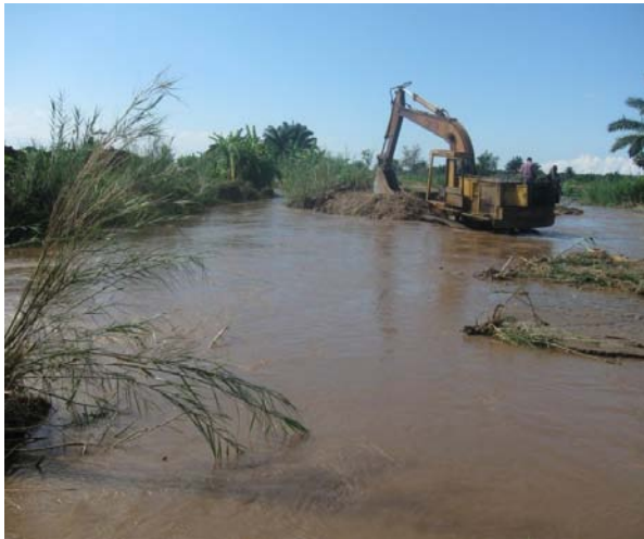
Photo 31 : Travaux de curage sur la rivière Mutimbuzi (guche), champ dévasté (droite) et l'aéroport menacé( en bas) après la rupture de la digue sur la rive droite.
