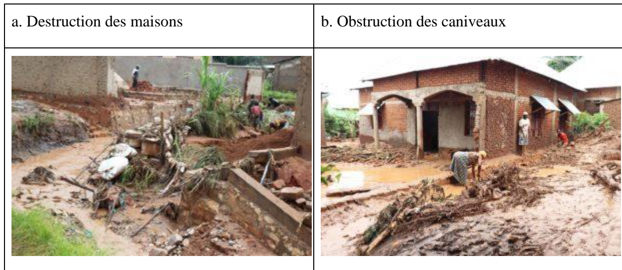
Figure I.3. Dégâts causés par la rivière Cari en 2019 1
