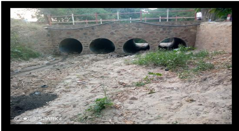
Photo 1: Image montrant l'ouvrage en buse sur l'avenue Gasibe
