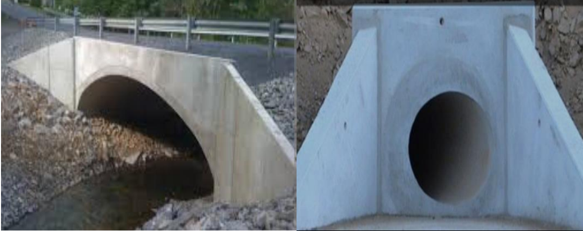
Figure 1 : Buse arche et buse circulaire
