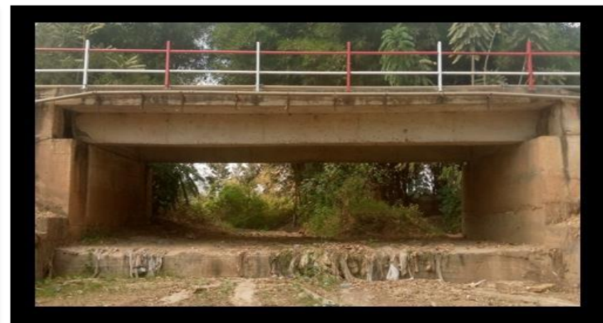
Photo 2: Image montrant le dalot sur l'avenue vers Iscam
