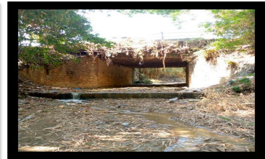
Photo 4: Image montrant le dalot sur la RN7
