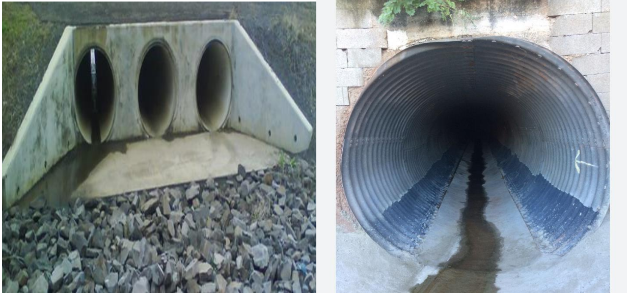
Figure 2: Buse circulaire en béton et buse en métal
