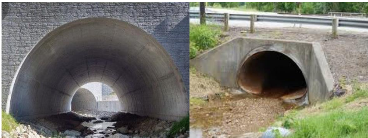
Figure 3: Buse arche en béton et buse arche en métal
