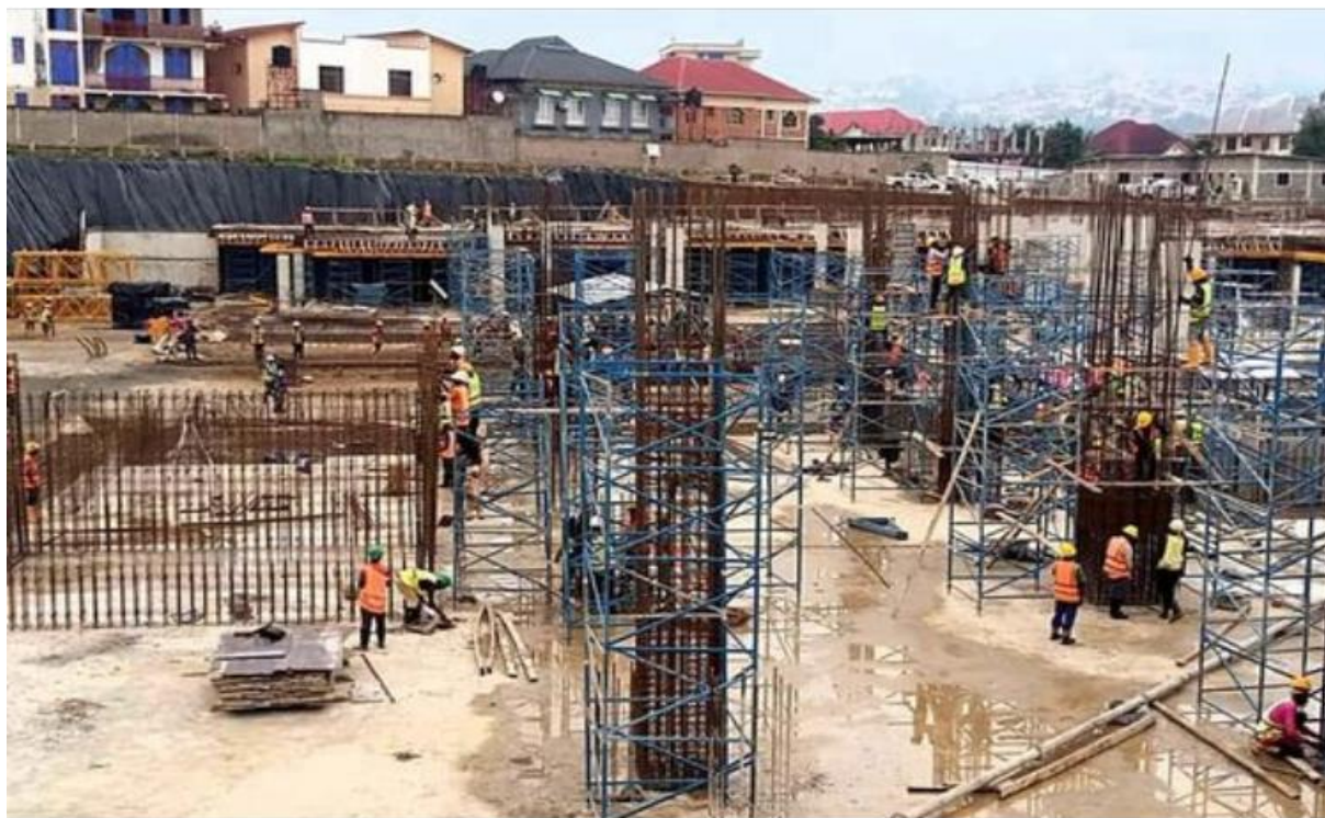
Figure 5-Chantier de construction de l'OBR (bâtiment de 12 niveaux)
