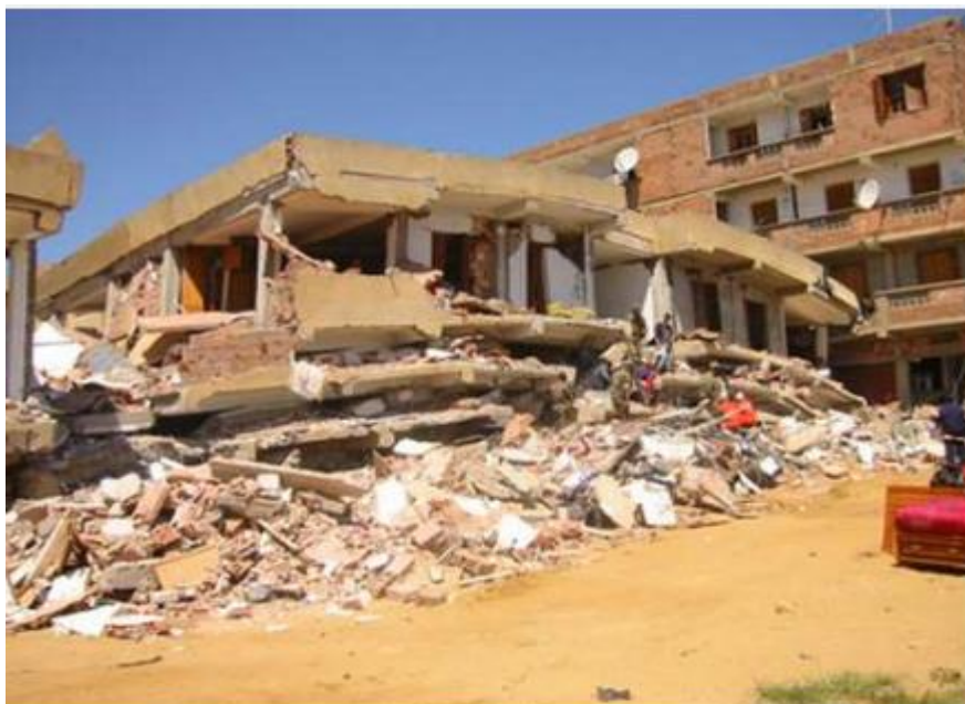
Figure 8-Ruine d'un bâtiment suite à un séisme à San Fernando
