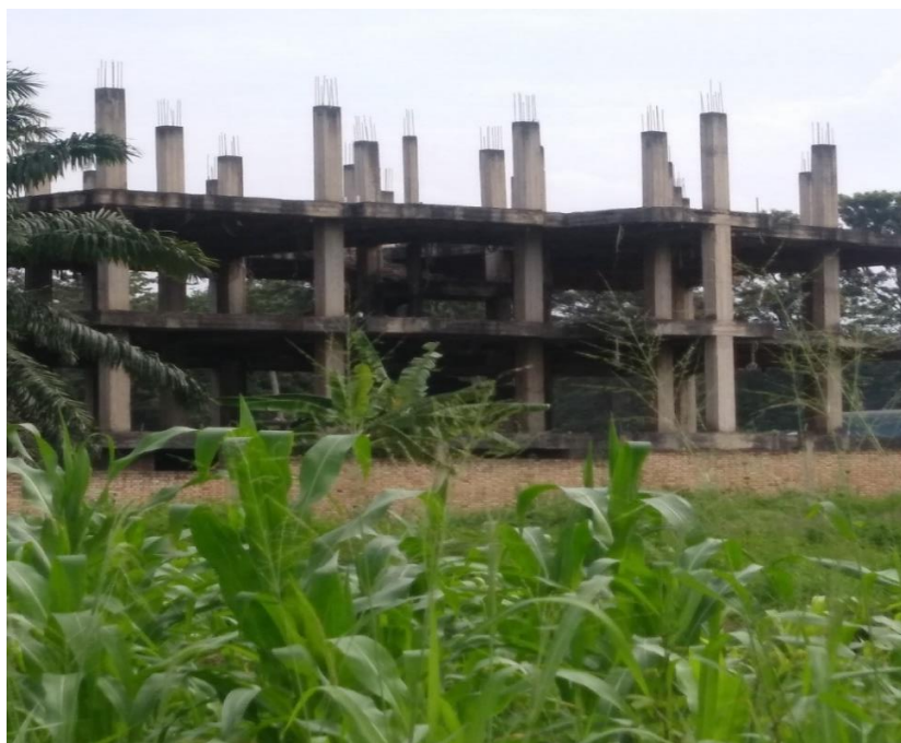
Figure 7- Structure en béton armé
