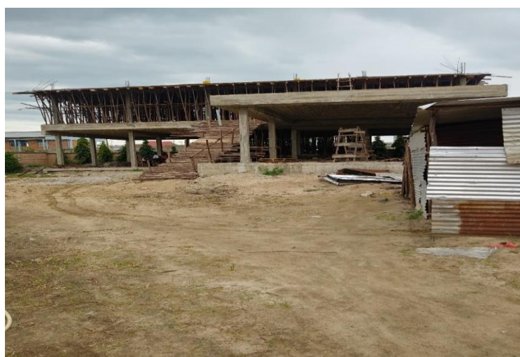
Figure 6-Structure en béton armé
