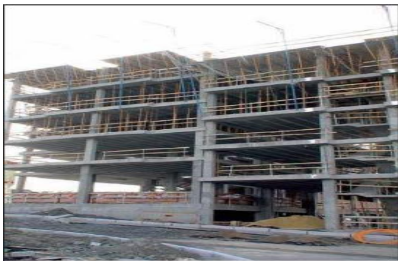
Figure 1- Structure en béton armé
