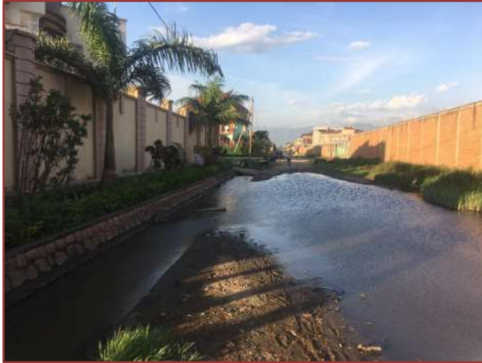
Fig.7. Débordement d'un réseau de canalisation (quartier Miroir, juin 2021)
