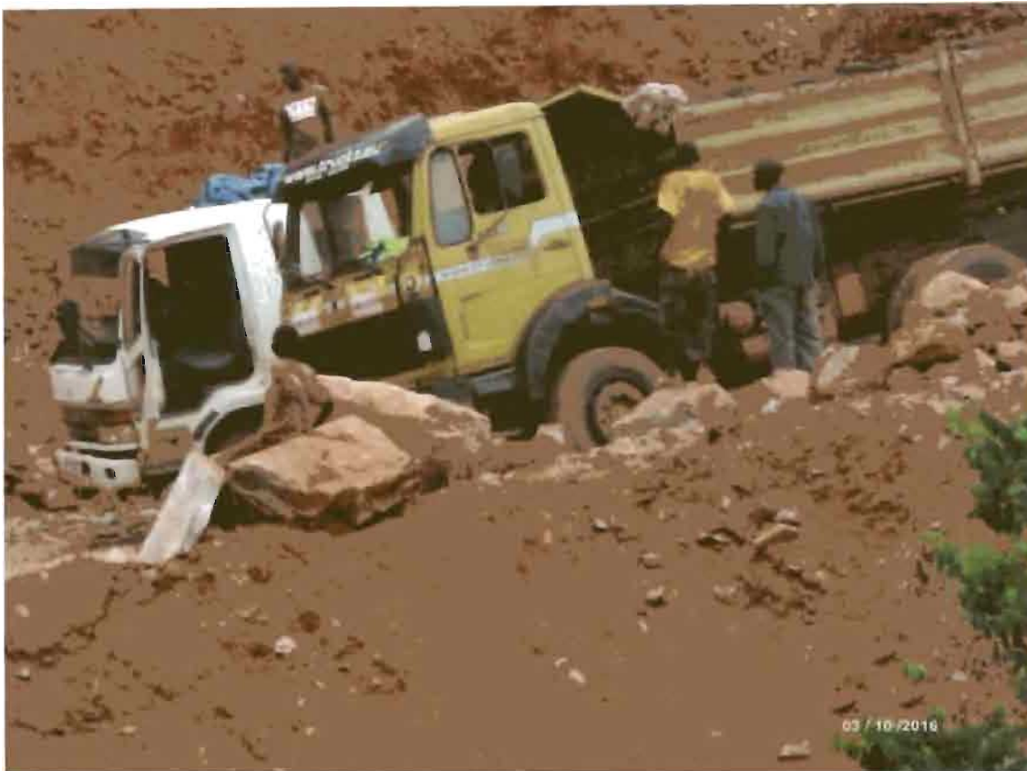
Photo 2: Zone de chargement des moellons
