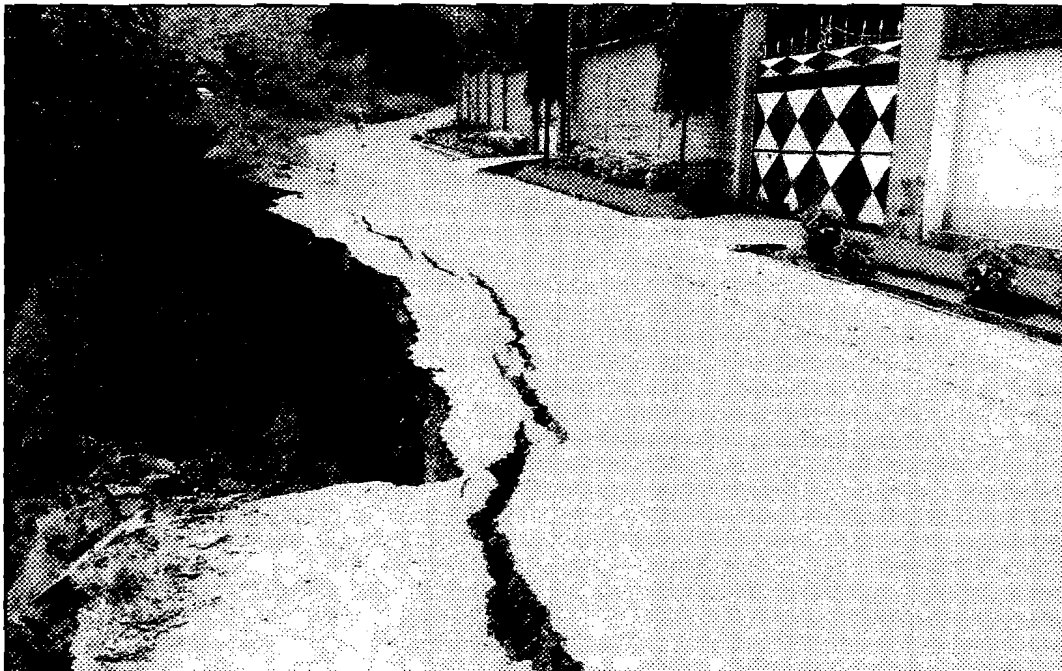
Photo 6: Quartier Mugoboka en voie d'isolement, la route Sanzu est presque coupée
