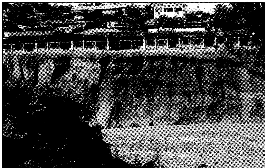
Photo 8: Menace de destruction de l'école primaire Mutanga-Sud sur la rive gauche de la Ntakangwa
