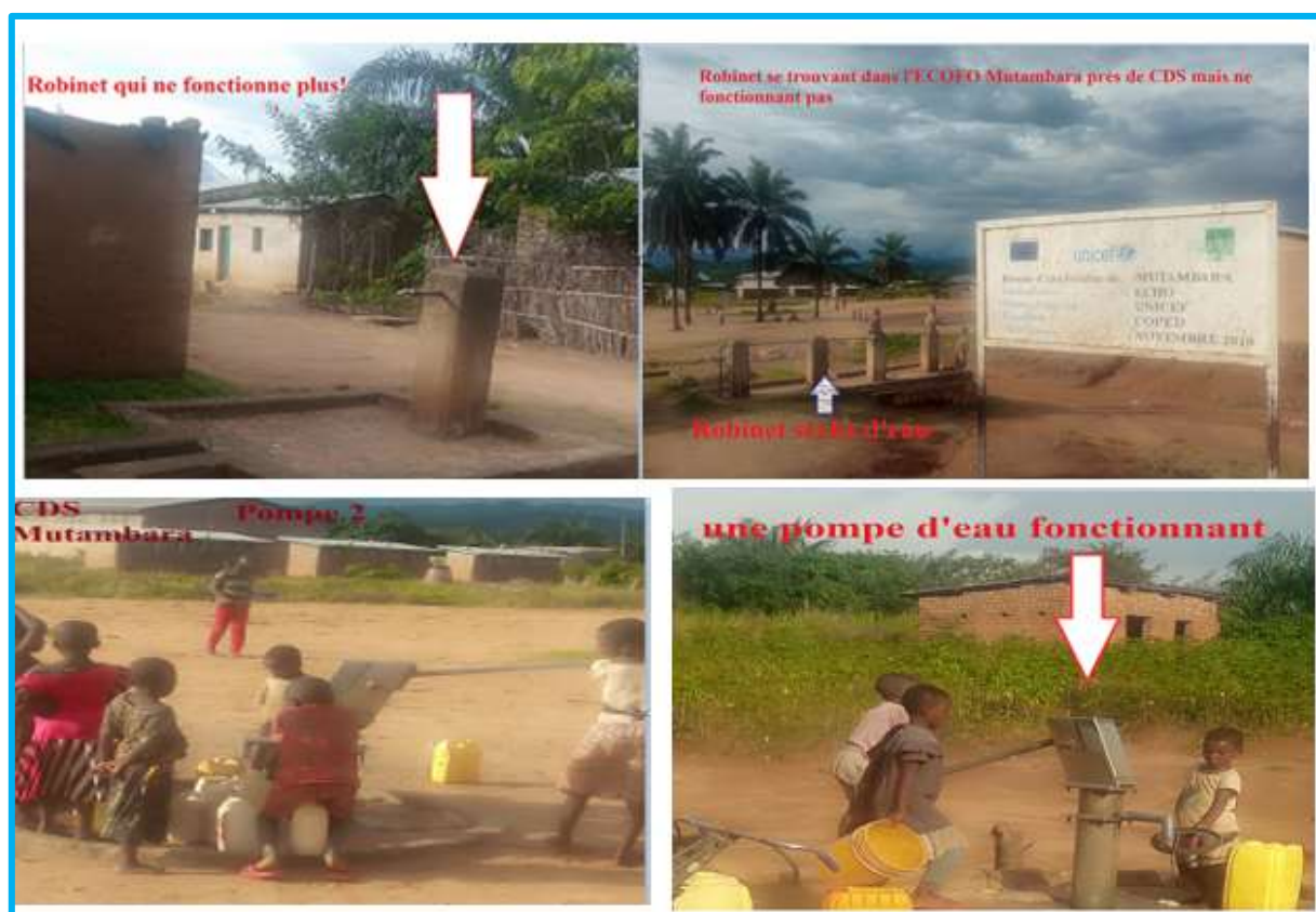
Photo 4.3, 4.4, 4.5 e 4.6: État actuel des infrastructures et équipements de base dans les VRI enquêtés.
